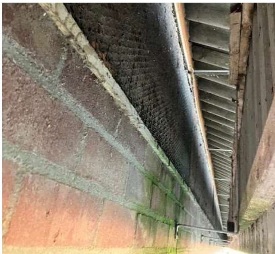
• Afbeelding 21: Luchtinlaten voorzien van gaas
