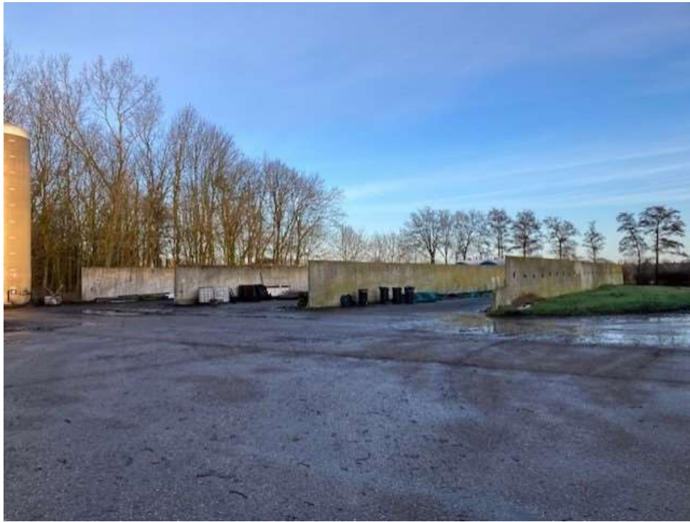
• Afbeelding 13: Te slopen sleufsilo's
