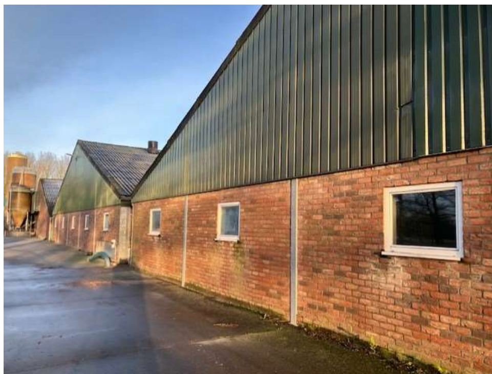
• Afbeelding 7: Te slopen stallen voorzijde
