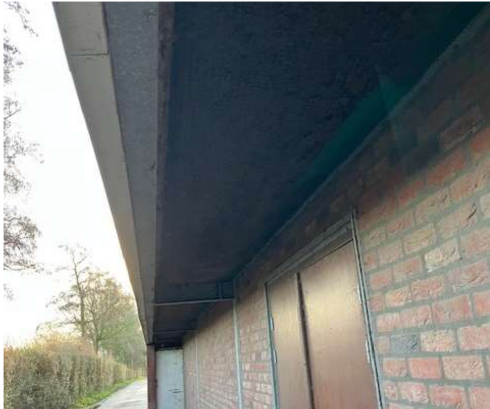
• Afbeelding 23: Luchtinlaat voorzien van gaas
