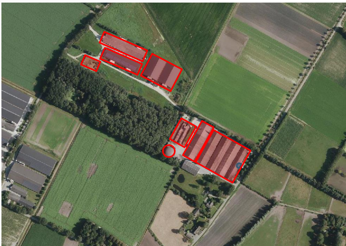
Figuur 3.1.1 Overzicht te slopen bebouwing locaties Huiskensweg en Rongvenweg
