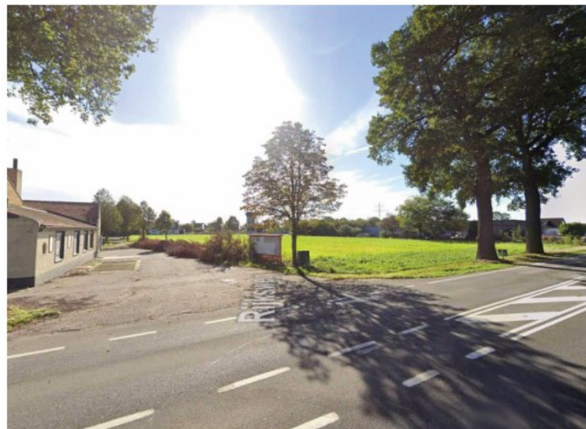
Figuur 12: Zicht vanaf de Rijksweg met links de voormalige Boerenbond en rechts de twee eikenbomen (Bron: Google Streetview)
