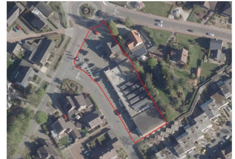
Figuur 3: Luchtfoto deelgebied Baarskampstraat en directe omgeving
