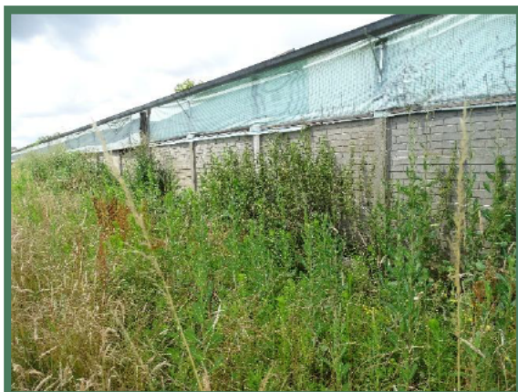
Foto 15: Oostgevel voormalige melkstal met ruigtevegetatie.
