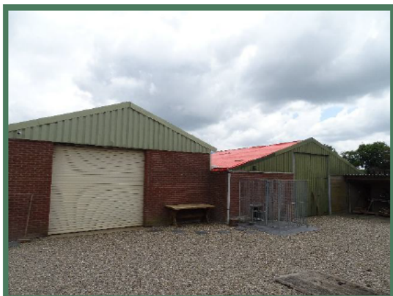
Foto 21: Zuidgevel oostelijke voormalige melkstal met afdak.
