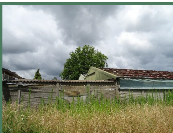
Foto 16: Aangebouwde schuur aan zuidgevel voormalige melkstal.
