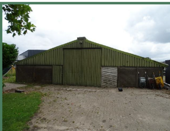
Foto 20: Zuidgevel westelijke voormalige melkstal.
