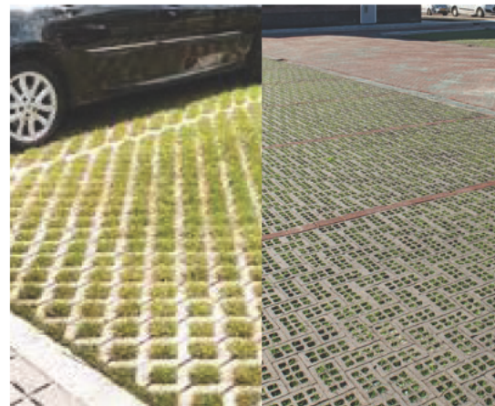
Parkeren op grasbeton / grasklinkers
