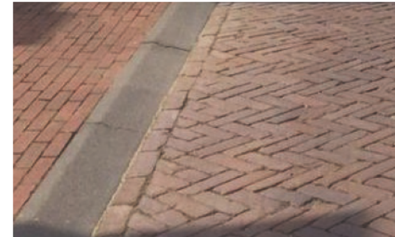
Rijbaan en trottoir (gebakken) klinker, overgang schuine band
