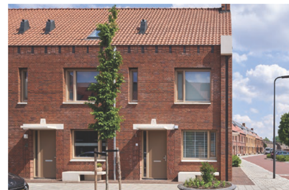
Speelse toevoeging van elementen en metselverbanden ter verrijking van een ingetogen dorpse bouwstijl
