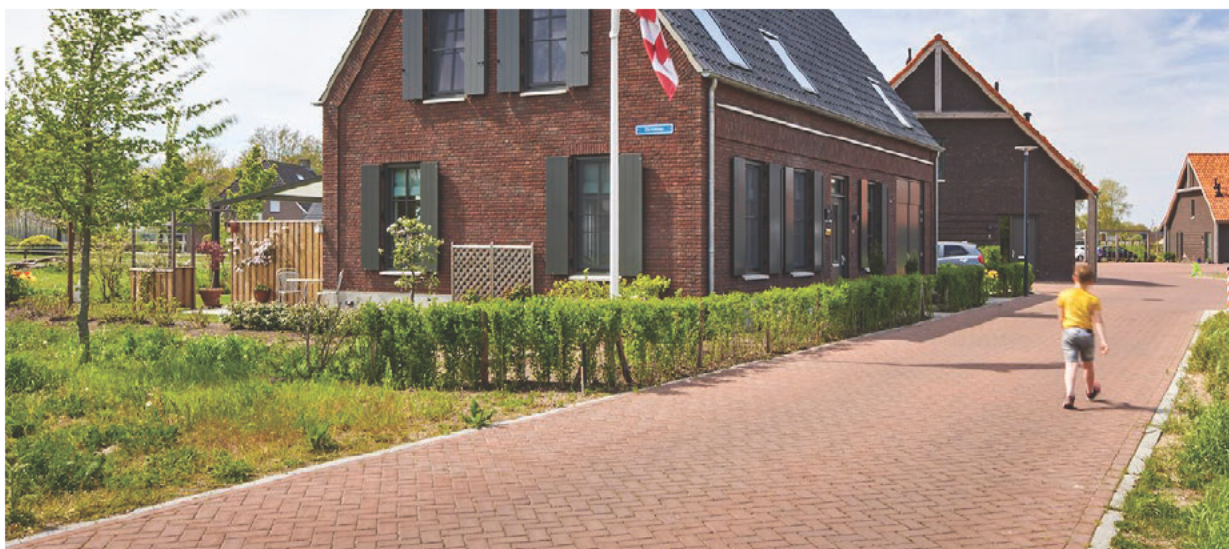
Informeel en autoluw hof met parkeren uit het zicht in parkeerkoffers
