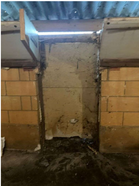
Versie 2; binnenzijde stal 1, deur
