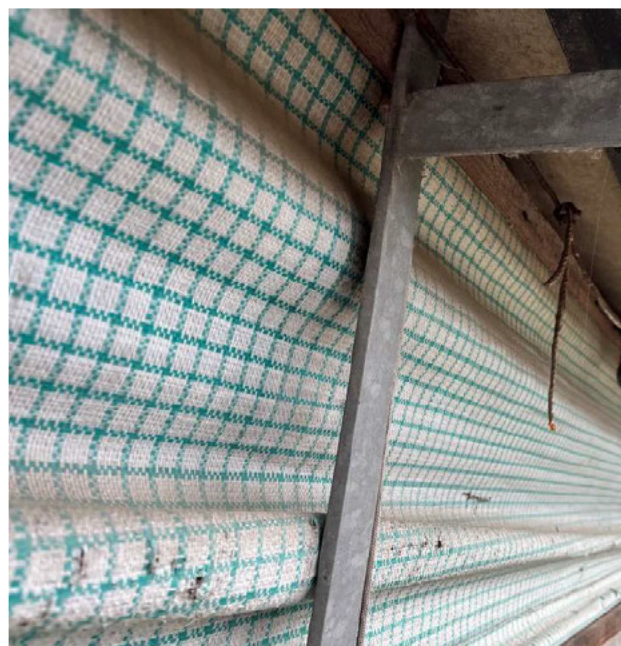
Versie 2; aftimmering bij goten, onder golfplaten
