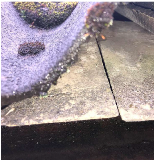
Aftimmering bij goten, onder golfplaten
