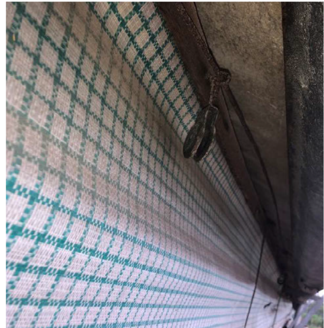
Aftimmering bij goten, onder golfplaten
