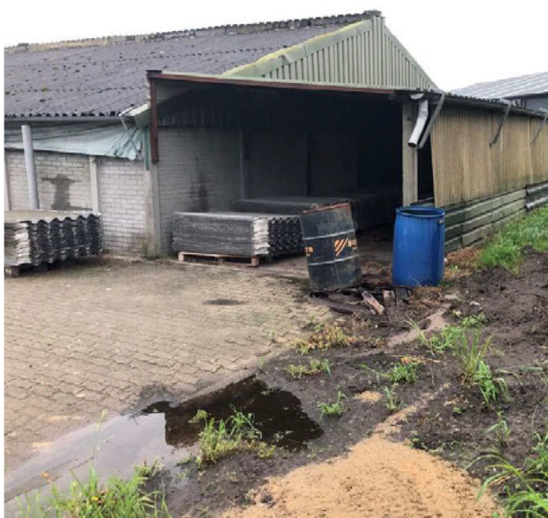
Afdak achter stal 1, damwand beplating
