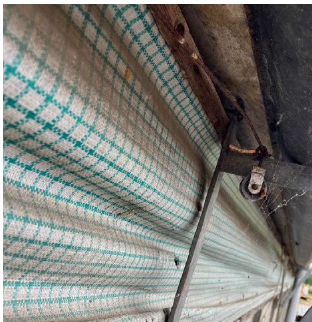
Versie 2; aftimmering bij goten, onder golfplaten
