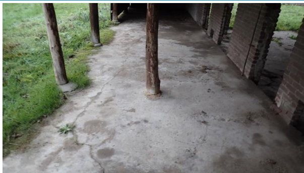
In de schuur geen verdachte materialen aanwezig
