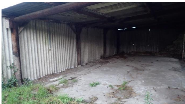
In de schuur geen verdachte materialen aanwezig
