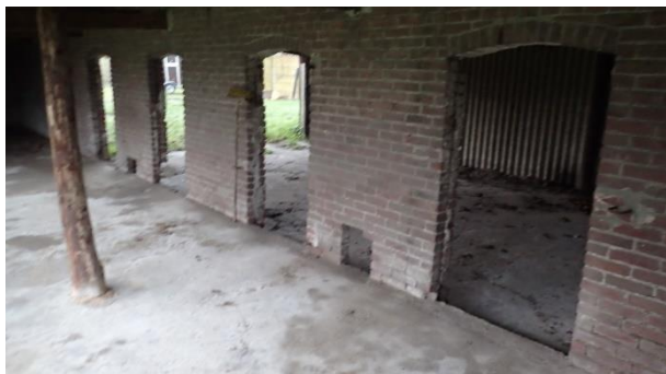
In de schuur geen verdachte materialen aanwezig
