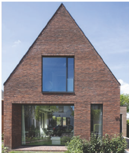
Primaire hoofdvorm in baksteen architectuur met moderne glazen uitsparingen
