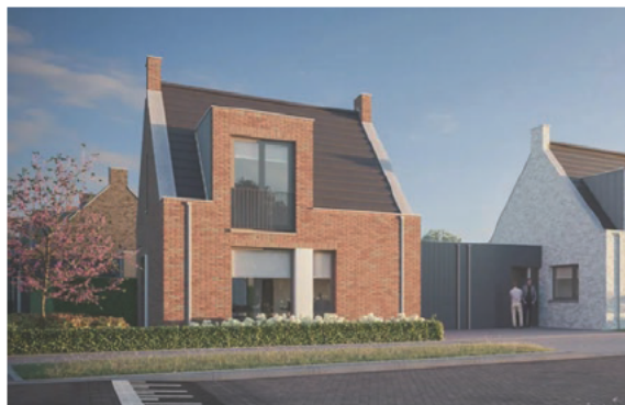
Baksteenarchitectuur met eigentijdse vormen, zoals doorzetting gevel in dakvlak
