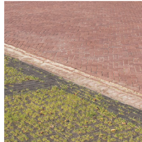
Erfverharding (gebakken) klinker
