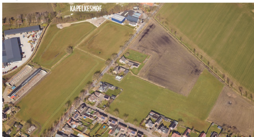
Locatie vanaf Roomweg
