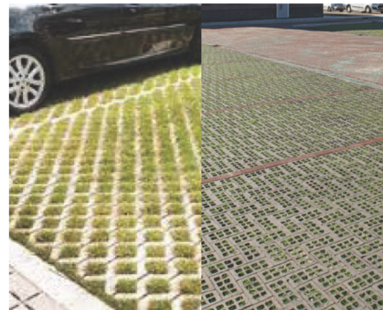
Parkeren op grasbeton / grasklinkers
