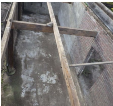
Foto 3 B / Verwijderde bron M-1
