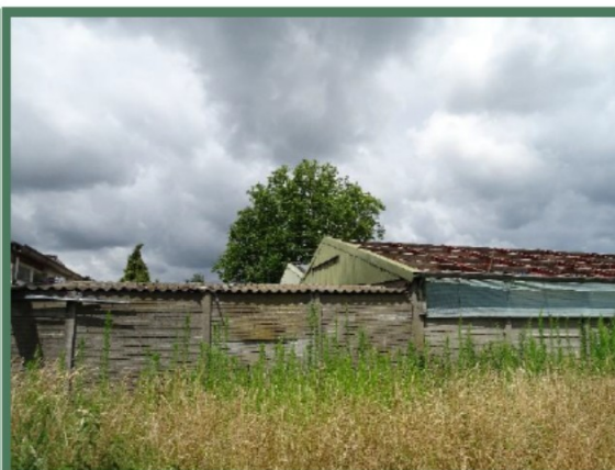
Foto 16: Aangebouwde schuur aan zuidgevel voormalige melkstal.
