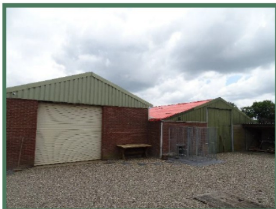
Foto 21: Zuidgevel oostelijke voormalige melkstal met afdak.
