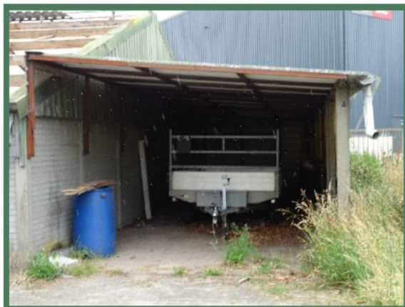
Foto 23: Afdak aan noordgevel oostelijke melkstal.
