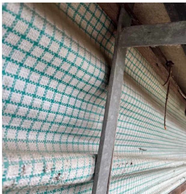
Versie 2; aftimmering bij goten, onder golfplaten
