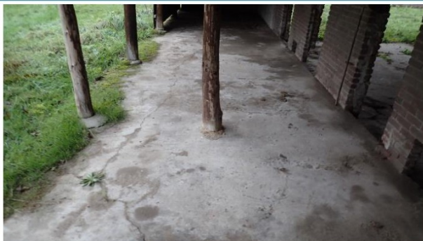
In de schuur geen verdachte materialen aanwezig
