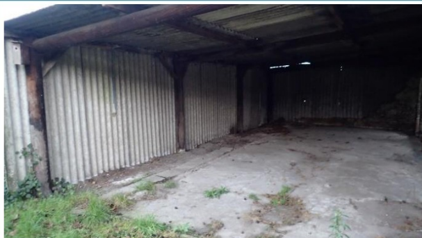
In de schuur geen verdachte materialen aanwezig
