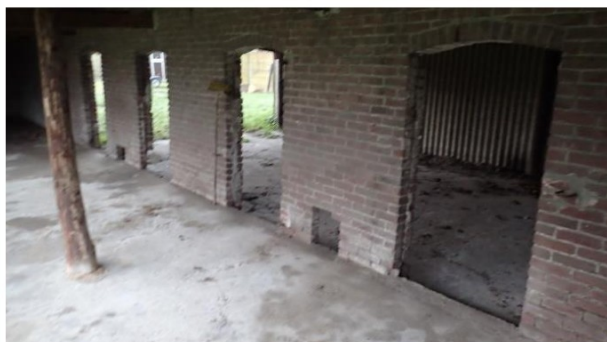
In de schuur geen verdachte materialen aanwezig
