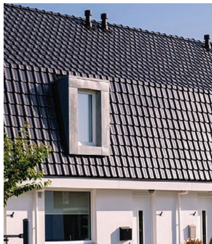
dak doorlopen in gevel
