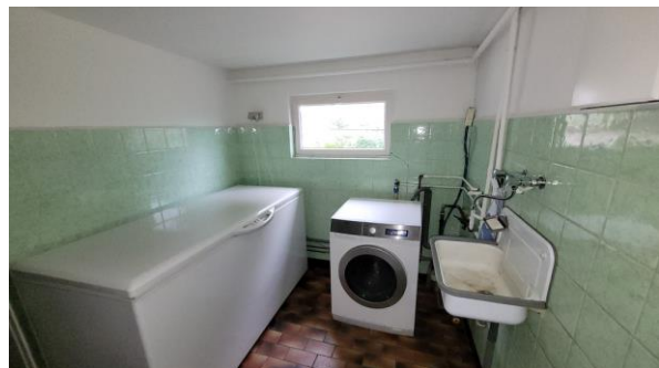
overzicht wasruimte, vloer niet verdacht
