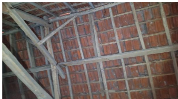
geen dakbeschot opstellen
