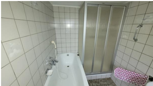
badkamer, vloer niet verdacht
