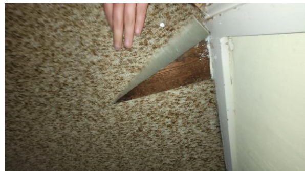
vloer 1e verdieping niet verdacht
