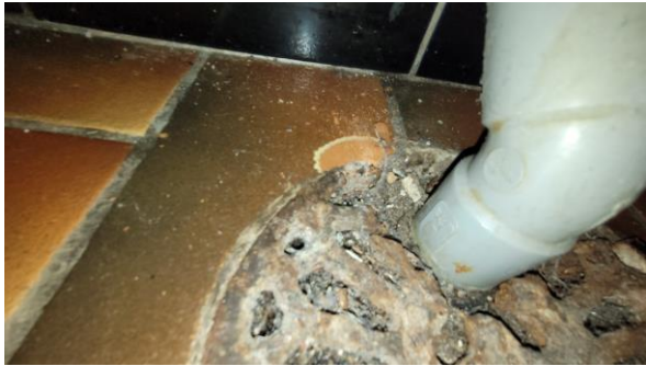
vloer niet verdacht
