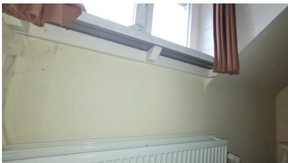
geen vensterbanken 1e verdieping
