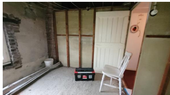
aanzicht achterzijde wand slaapkamer
