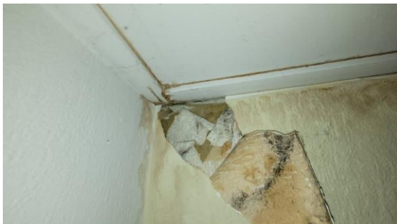
plaatmateriaal als wand
