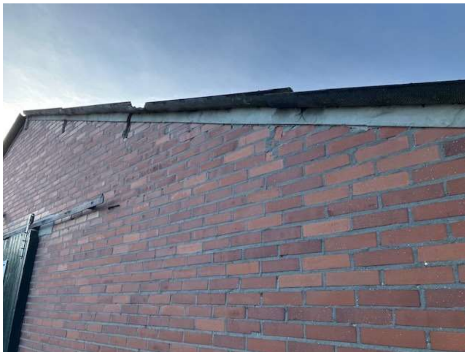
• Afbeelding 17: aansluiting van het dak in de voorgevel van de te slopen stal
