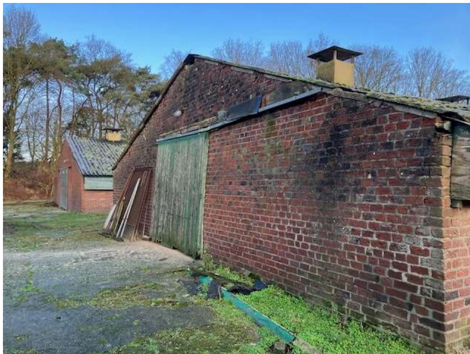
• Afbeelding 10: Achterzijde te slopen stal
