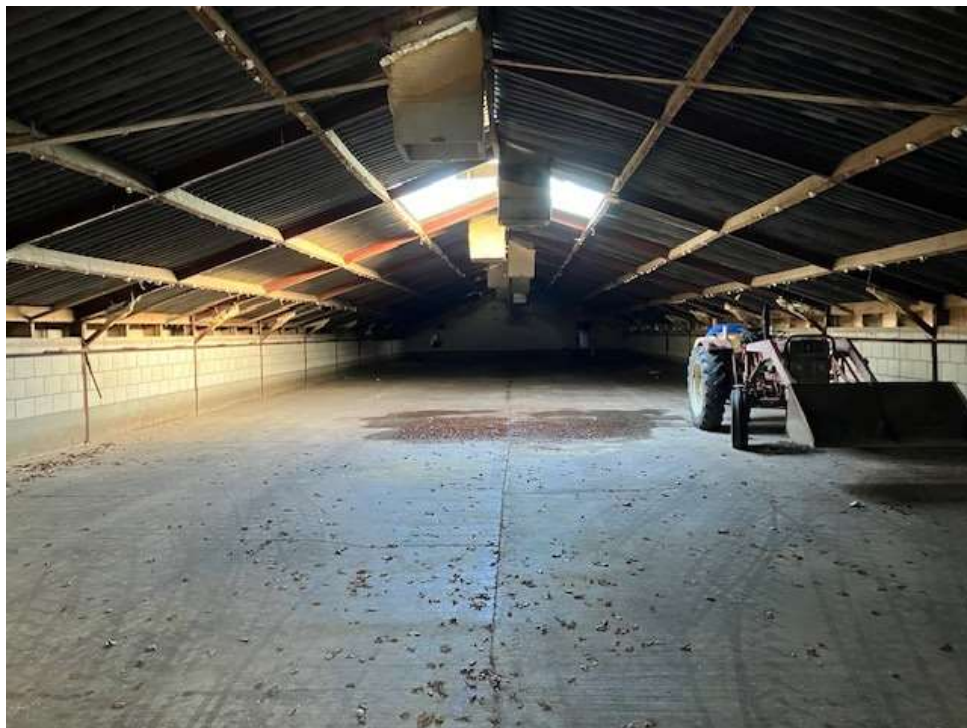
• Afbeelding 14: binnenzijde te slopen stal, isolatie en plafondplaten zijn reeds verwijderd
