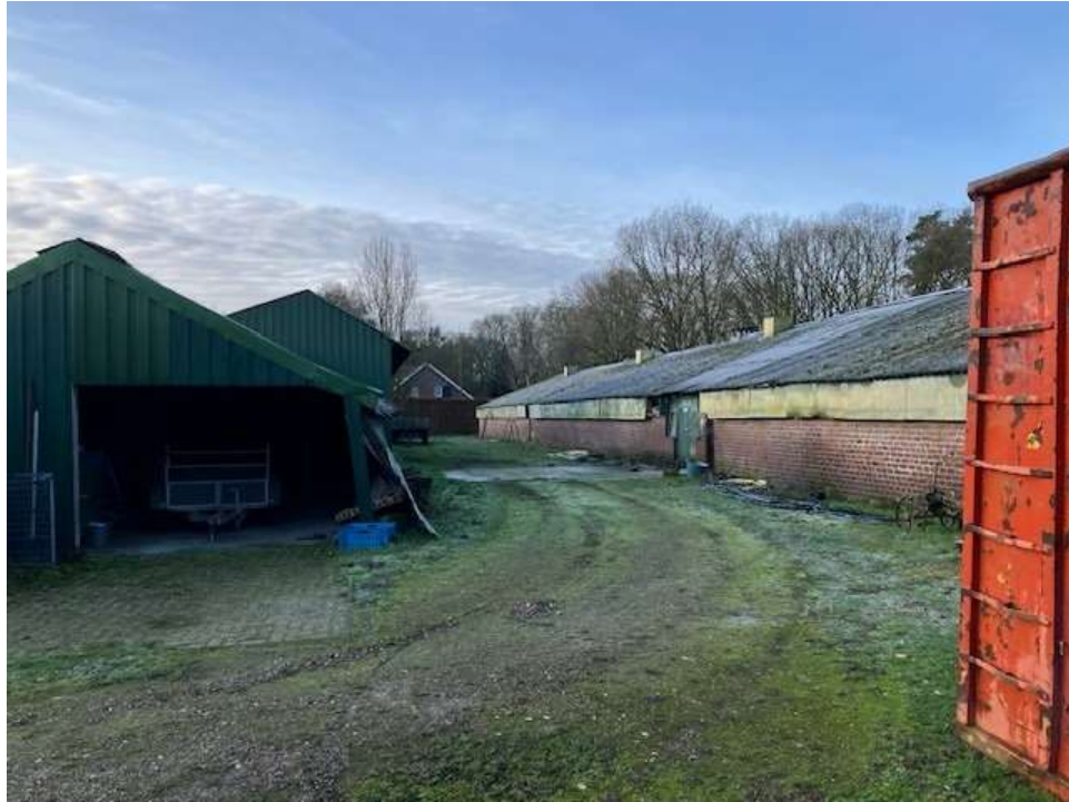
• Afbeelding 5: te slopen bebouwing
