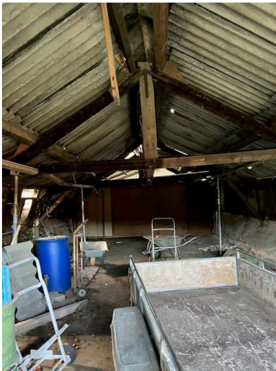
• Afbeelding 8: binnenzijde te slopen stal
