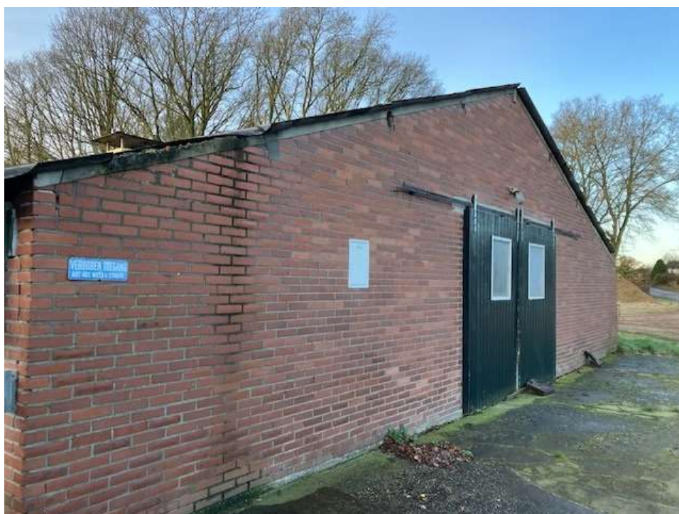
• Afbeelding 18: voorgevel van de te slopen stal
