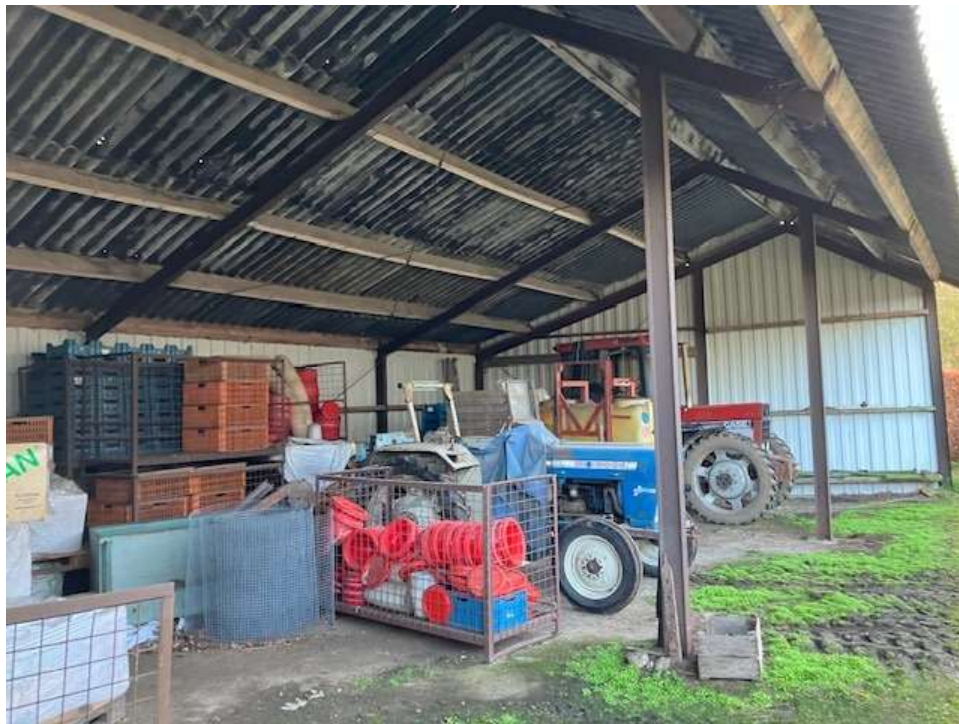
• Afbeelding 9: te slopen veldschuur
