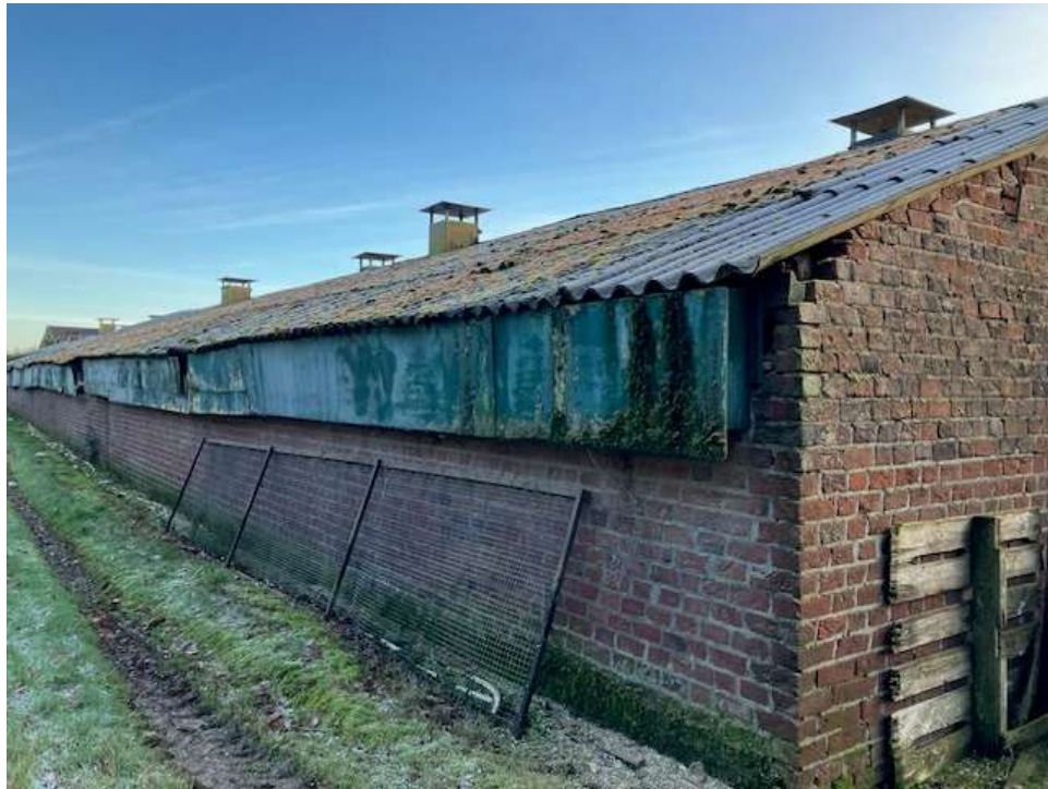
• Afbeelding 13: langsgevel te slopen stal
