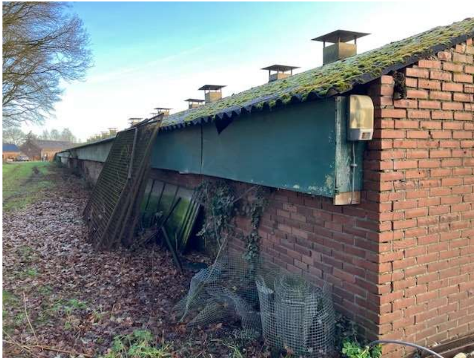
• Afbeelding 15: langsgevel te slopen stal
