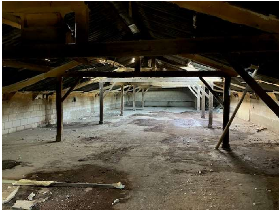
• Afbeelding 19: Binnenzijde voormalige pluimveestal, staat al heel lang leeg
