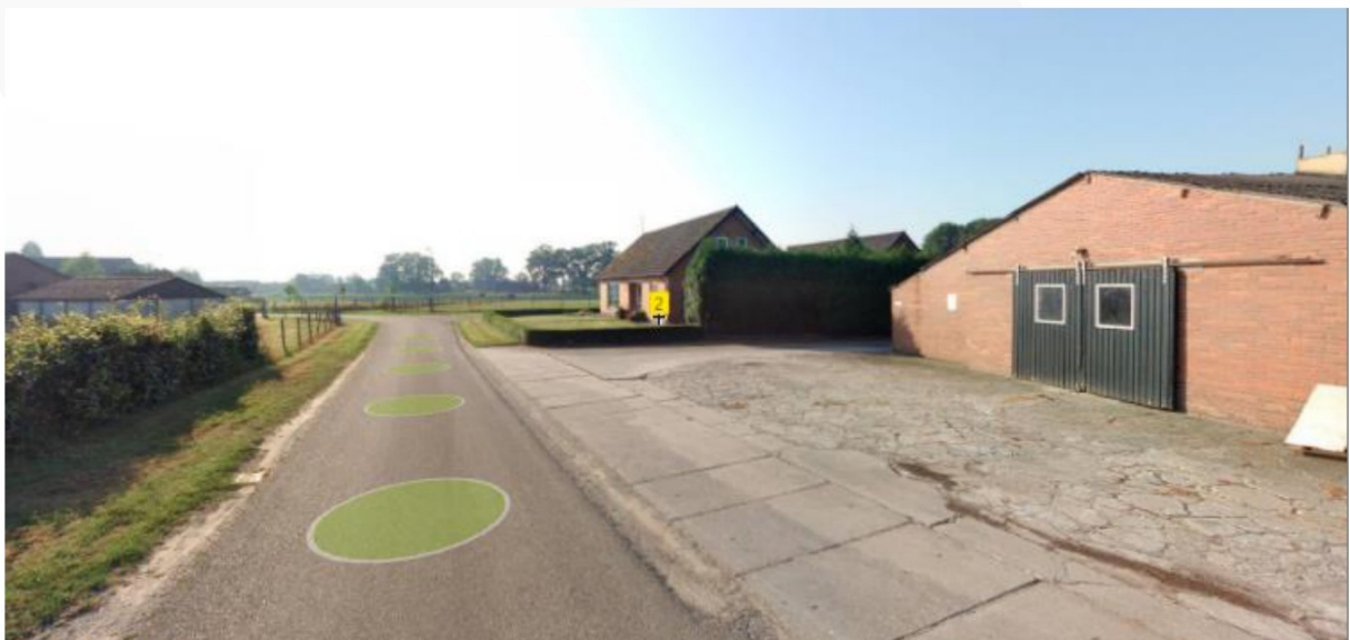
Figuur 2.2.2 Impressie Peelweg, Kessel (bron: streetsmart.cyclomedia.com)
