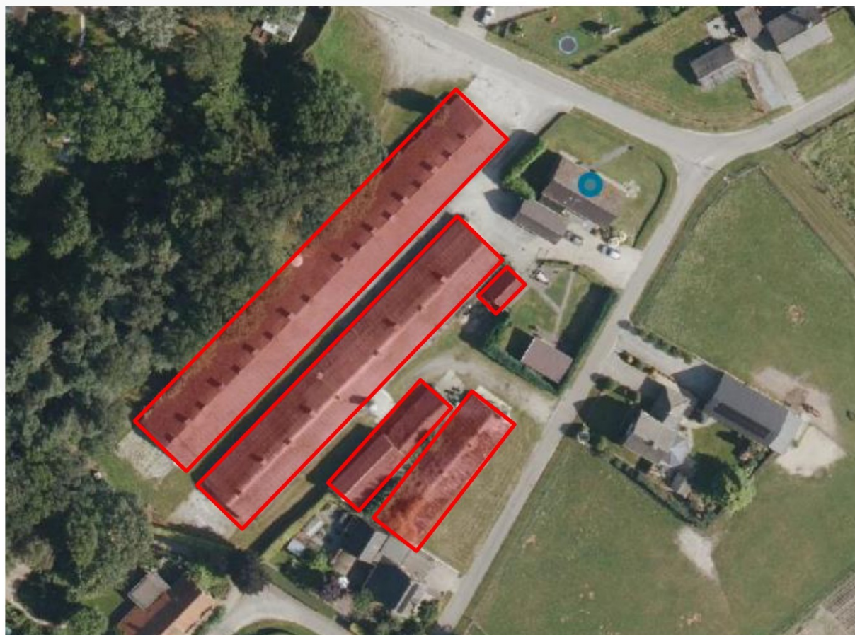
Figuur 3.1.1 Overzicht te slopen bebouwing Peelweg
