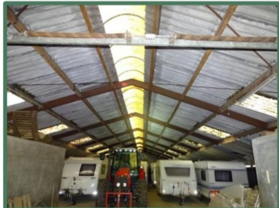
Foto 12: Binnenzijde oude stal.
