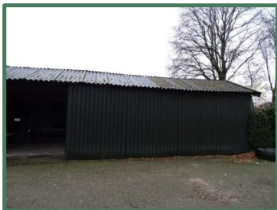
Foto 3: Oostzijde halfopen schuur.
