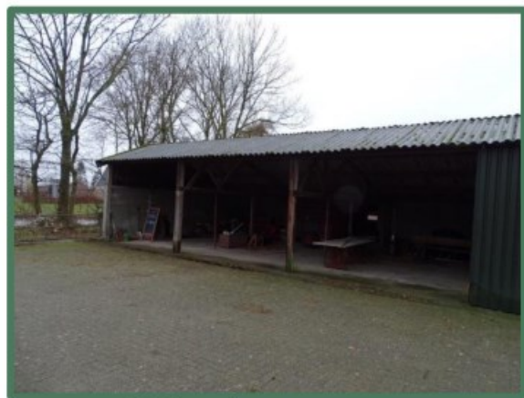
Foto 2: Oostzijde halfopen schuur.
