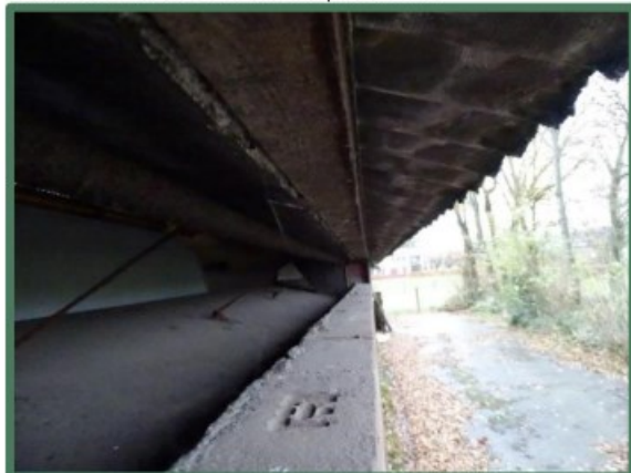
Foto 23: Dichte bovenkant gevels bij ventilatie openingen.
