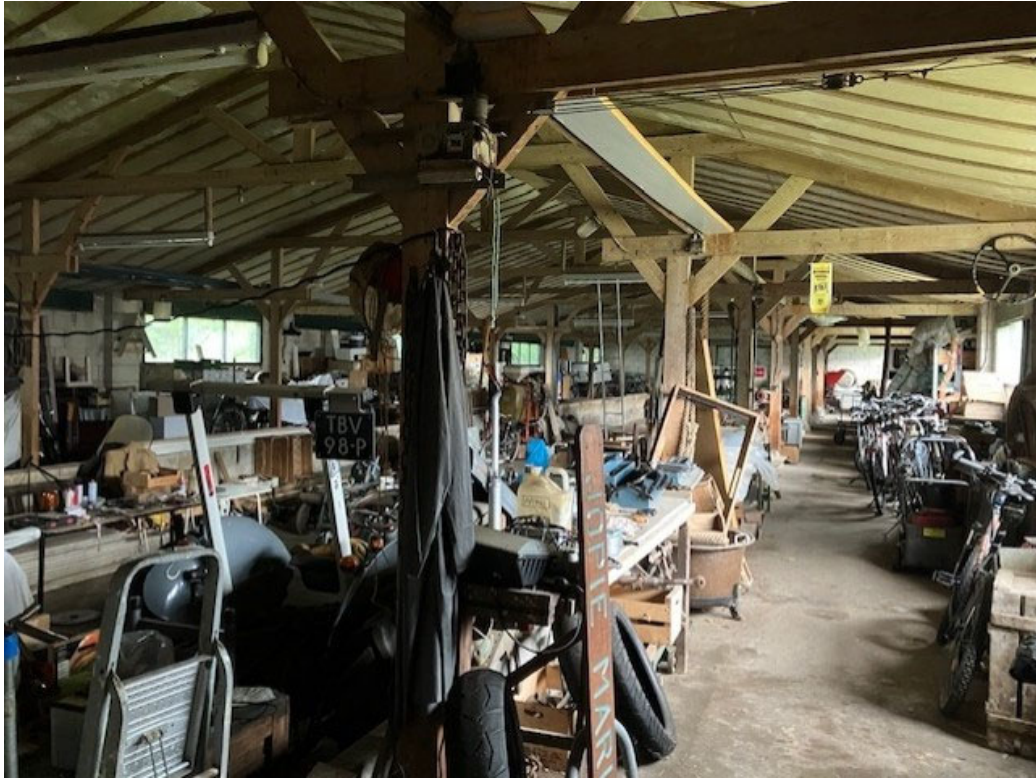
• Afbeelding 5: Binnenzijde te slopen kippenstal
