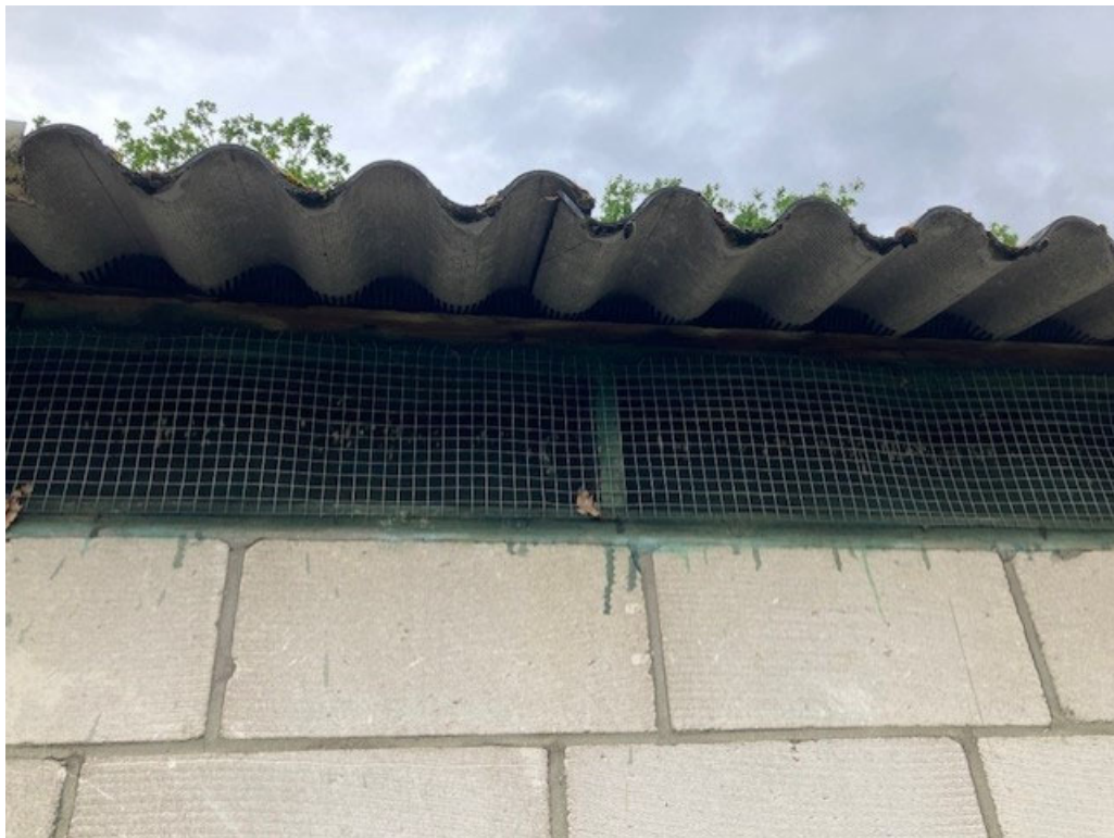
• Afbeelding 6: luchtinlaat voorzien van gaas
