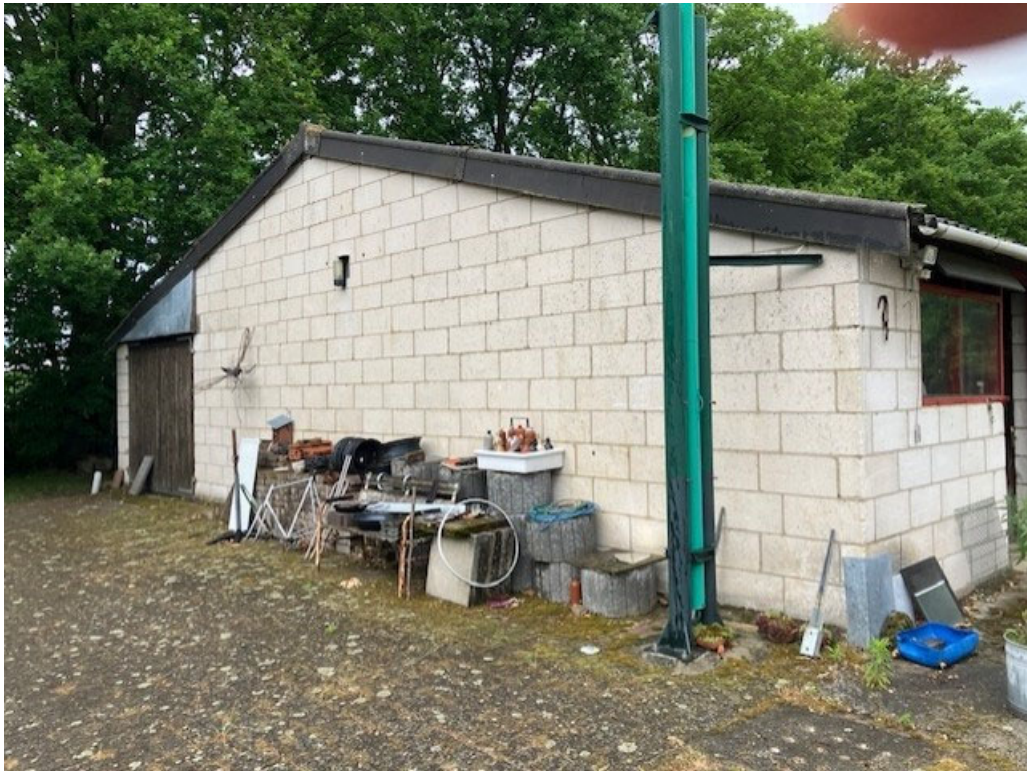
• Afbeelding 7: Voorzijde te slopen kippenstal
