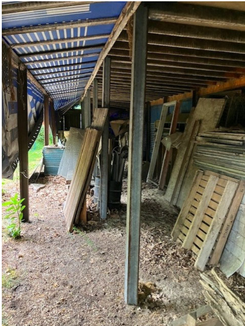
• Afbeelding 11: Afdak dat wordt gesloopt
