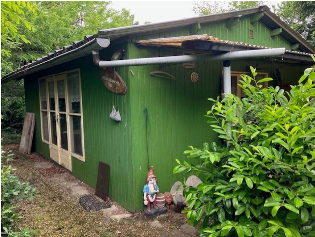
• Afbeelding 15: Voormalig vakantiehuisje wordt ook gesloopt
