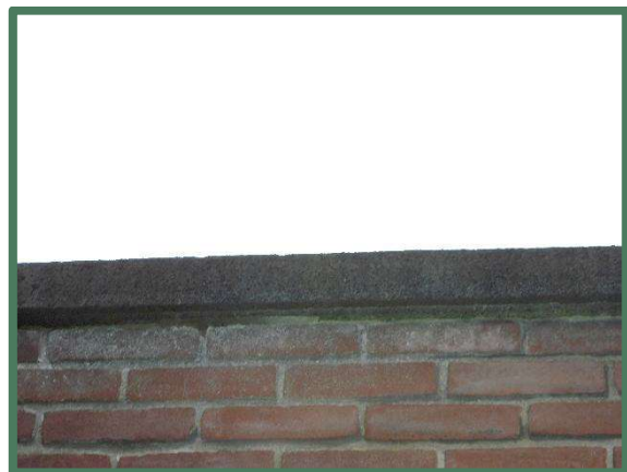
Foto 33: Betonnen dakrand zonder kieren.
