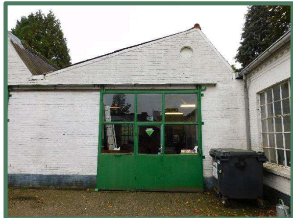
Foto 12: Noordzijde oostelijke deel werkplaats/showroom (3b).
