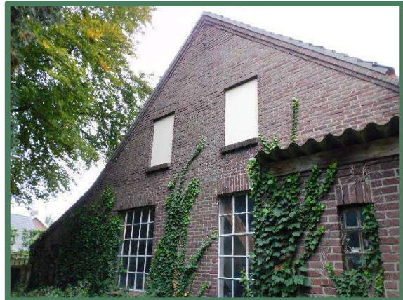
Foto 16: Zuidzijde westelijke deel werkplaats/showroom (3a).
