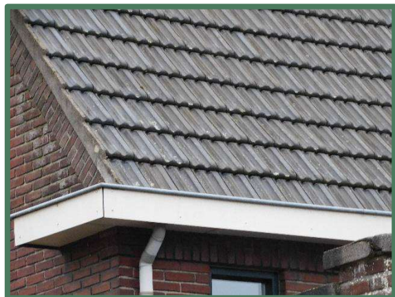
Foto 45: Aangesmeerde kopgevel en platte dakpannen lopen door tot in de goot met overstek, woning.
