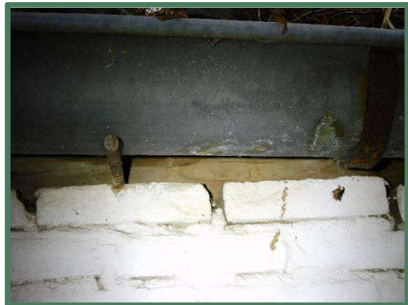
Foto 42 & 43: Muurplaat op de muren en openingen gedicht met (oud) purschuim werkplaats/showroom.
