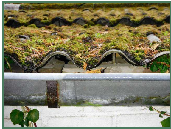
Foto 35: Houten lat onder golfplaten dak werkplaats/showroom.
