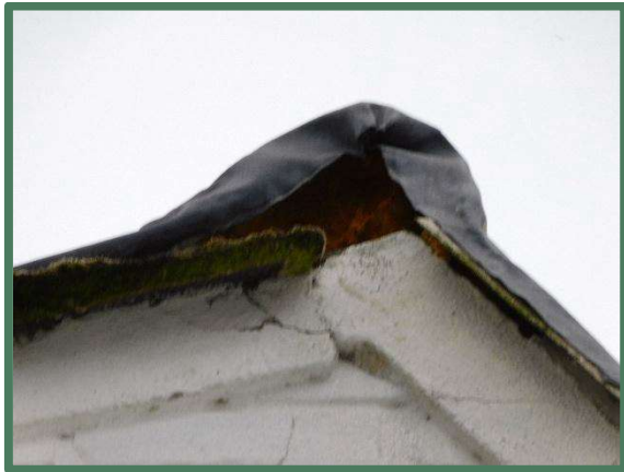
Foto 40: Openingen gedicht met (oud) purschuim werkplaats.
