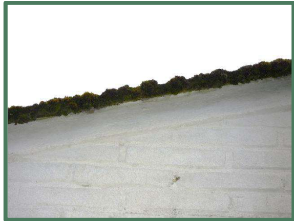
Foto 41: Golfplaten liggen direct op de gevels zonder kieren.
