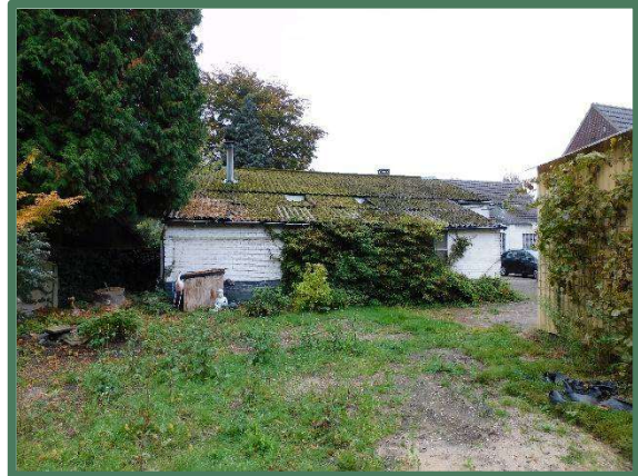
Foto 14: Oostzijde oostelijke deel werkplaats/showroom (3b).
