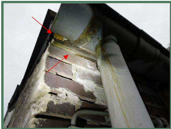
Foto 42 & 43: Muurplaat op de muren en openingen gedicht met (oud) purschuim werkplaats/showroom.
