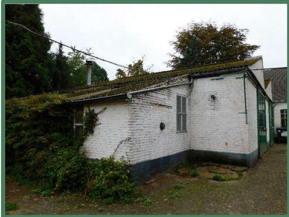
Foto 13: Noordoostzijde oostelijke deel werkplaats/showroom (3b).
