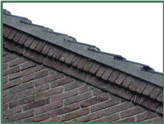
Foto 34: Aangesmeerde kopgevel werkplaats/showroom.
