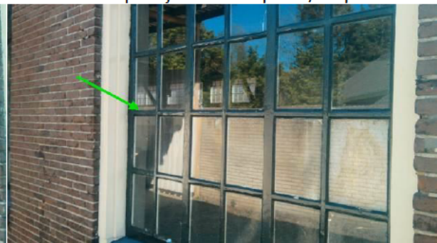
Foto 21 | kozijnen met vulpasta / stopverf
