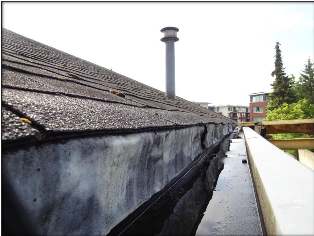
Figuur 4.2. Dakbedekking ter plaatse van de te slopen loods, volledig afgesloten.
