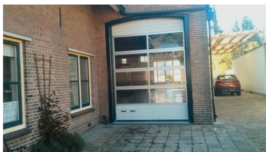
Woning en garage
