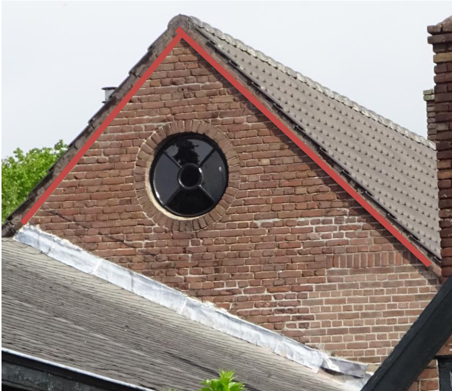
Figuur 4.4. Aansluitende gevel straks afgewerkt met specie.
