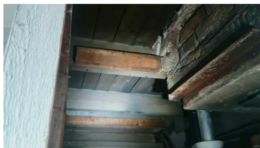
Schoorsteen en houten balklaag
