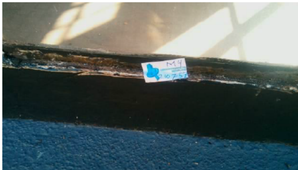
Foto 18 | kozijnen met vulpasta / stopverf
