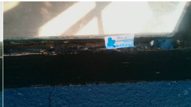
Foto 19 | kozijnen met vulpasta / stopverf
