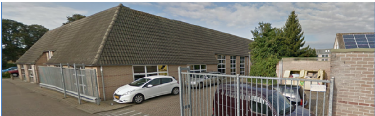
Figuur: Magazijn gezien vanaf oostzijde
