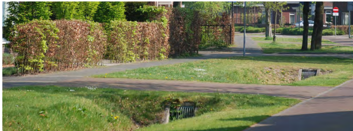
Droge greppel voor waterverplaatsing tijdens piekmomenten
