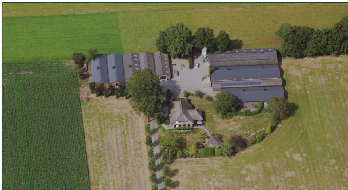
Afbeelding, bouwlocatie Oude Nijkerkerweg 32 (Bron: Street Smart)
