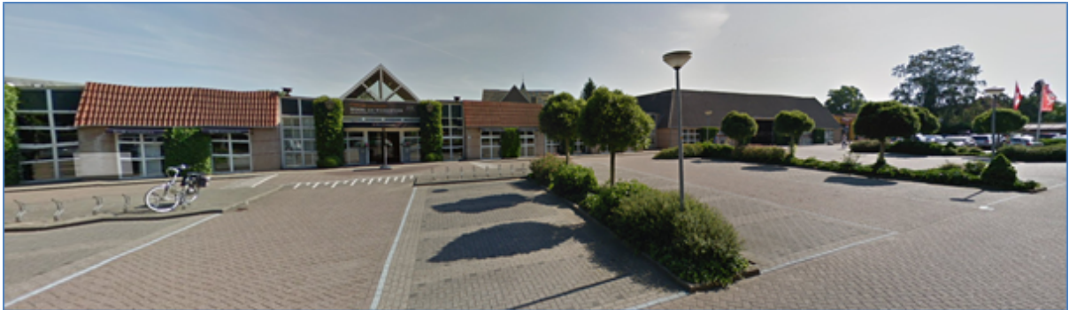
Figuur: Pand gezien vanaf Gervenhof (zuidzijde)
