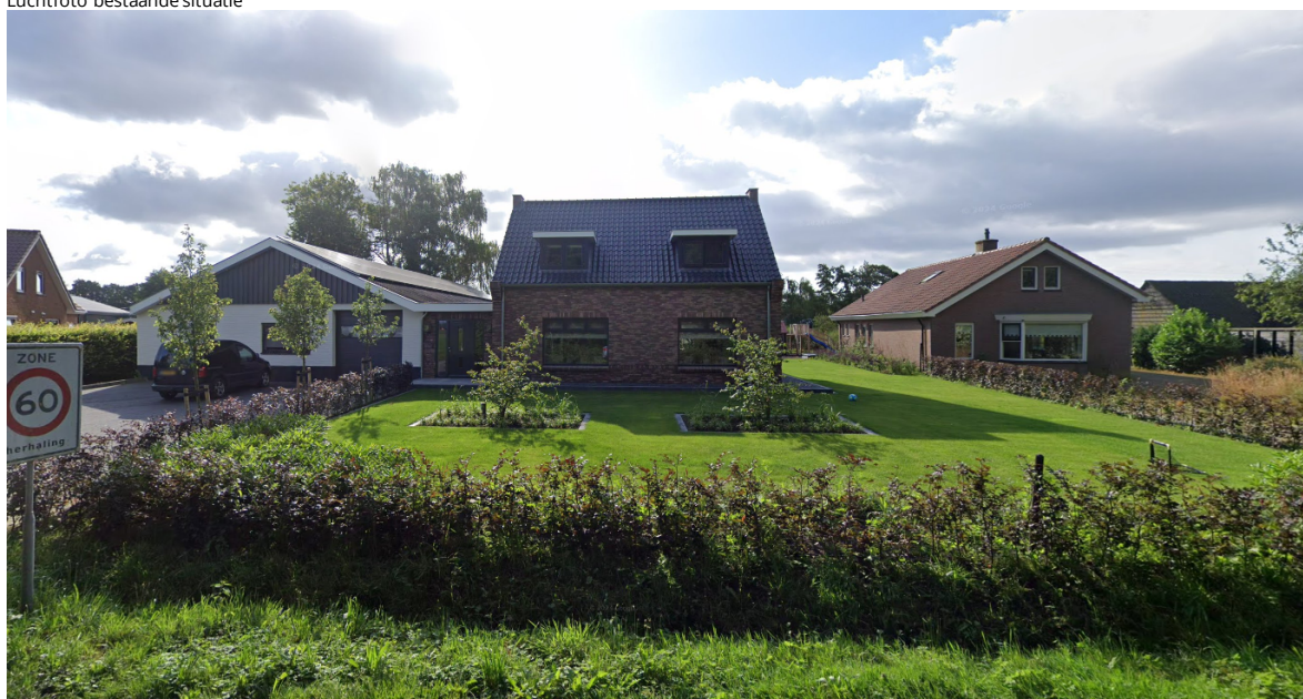
Vooraanzicht bedrijfsgebouw (links) en bedrijfswoningen (midden en rechts) vanaf de Waterweg
