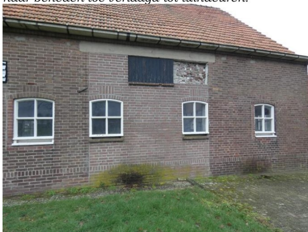
Voormalige poortopening onder betonlatei: kenmerkend opzet voor de jaren dertig.
