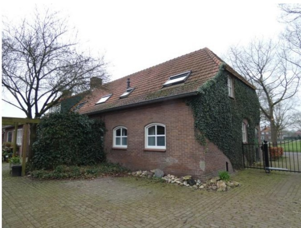
Achtergevel van het achterhuis: rechter gedeelte.
