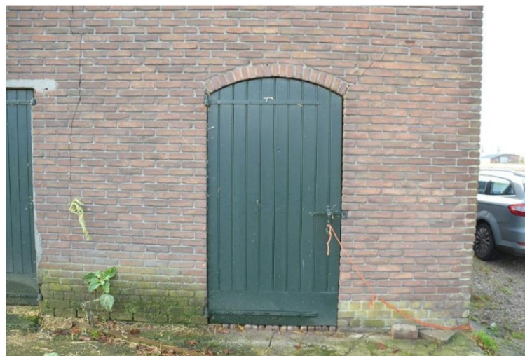
Rond de loopdeur is geen inboetwerk zichtbaar. De opening is dus oorspronkelijk.
