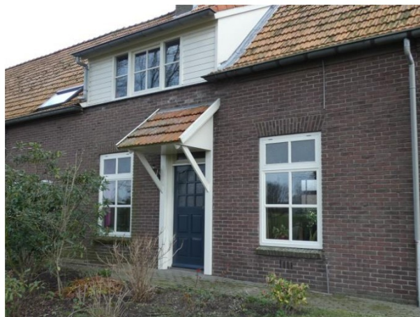
Symmetrische opzet gevel voorhuis met vensters onder hanenkam. De luifel en kapel zijn later toegevoegd.
