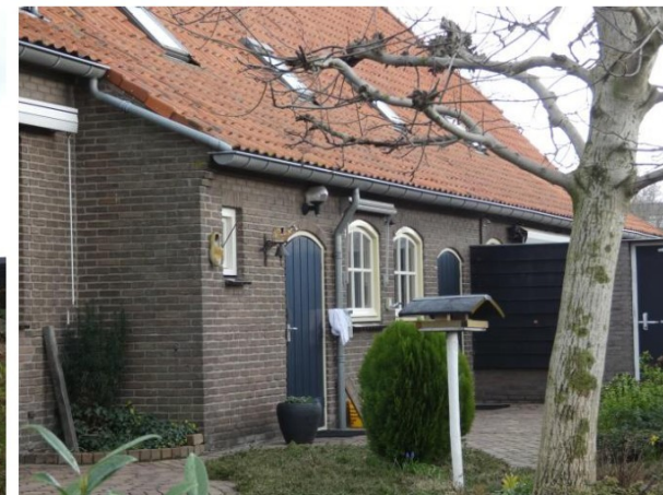
De oorspronkelijke uitbouw tegen het achterhuis, waarbij de venster- en deurstructuur is behouden.
