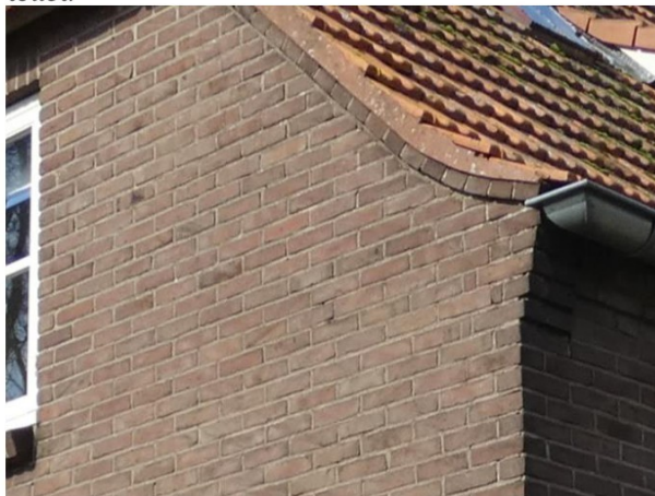
Detail van de zuidgevel: schouder en licht-uitkragende platte lijst.
