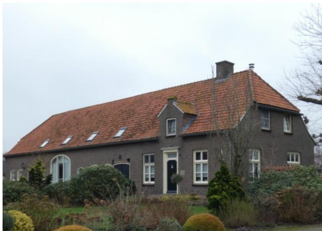
Noord- en oostgevel.
