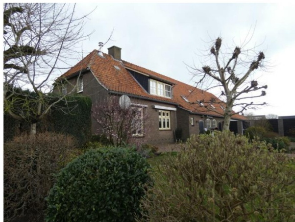
Achtergevel (zuidgevel) van het voorhuis.
