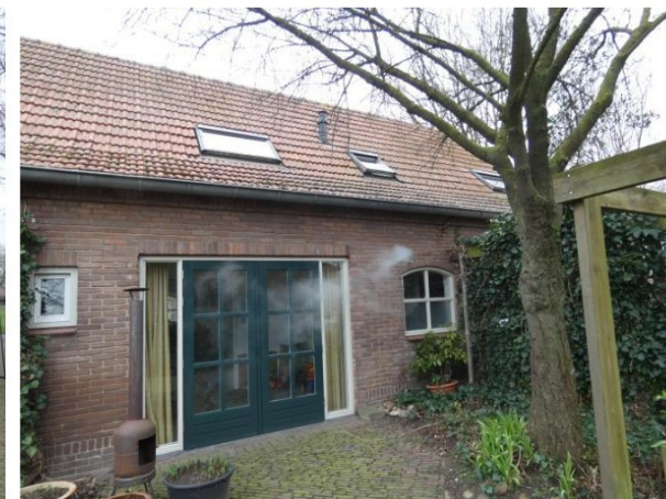
Centrale gedeelte gevel van het achterhuis. De pui met tuindeuren vervangt een staldeur en -venster.
