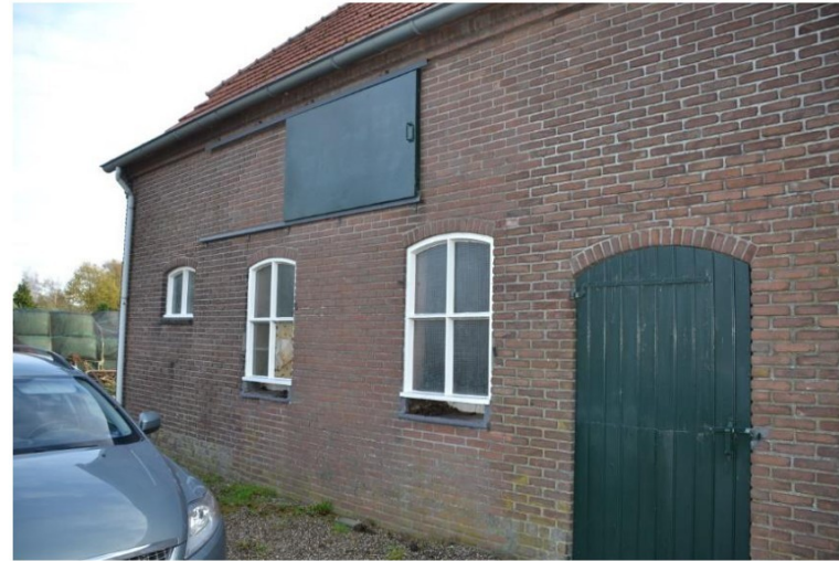
Linkerzijde van linkerzijgevel met zichtbaar inboetwerk van de vm. deeldeuropening.
