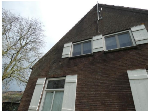
Detail van de westgevel, gemetseld in staand verband.
