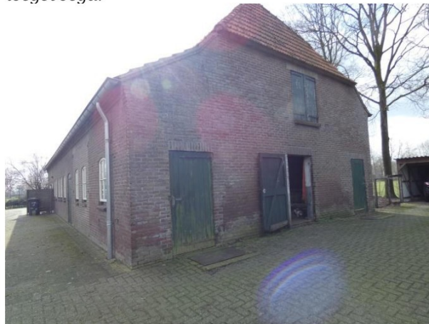
Achtergevel: de staldeuren op de begane grond zijn later toegevoegd.
