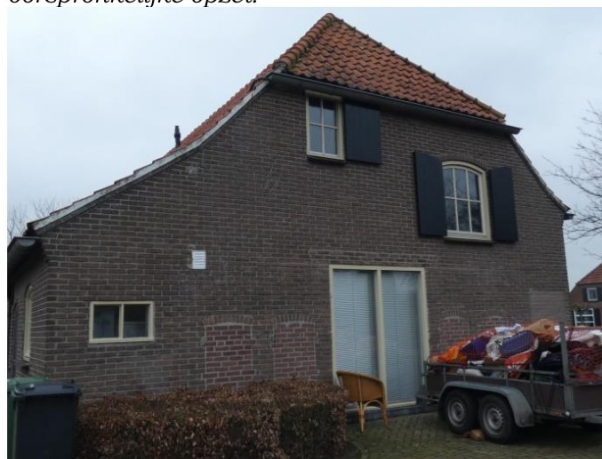
Oostelijke kopgevel. Het grote venster is in opzet niet authentiek. De dichtgezette lage staldeurtjes zijn duidelijk herkenbaar.
