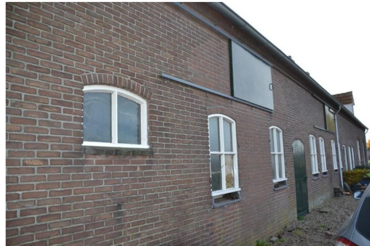
Linkerdeel van linkerzijgevel vanuit het noorden gezien.
