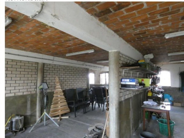
Interieur: voormalige grupstal: karakteristieke constructie met plafond van holle bakstenen.
