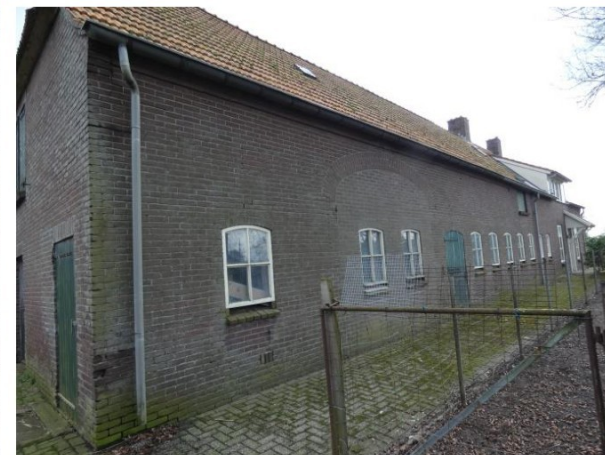
Westgevel van het achterhuis. De voormalige poortopening onder korfboog is nog duidelijk herkenbaar.
