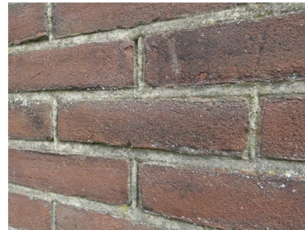
Knipvoegjes bij de stootvoegen.
