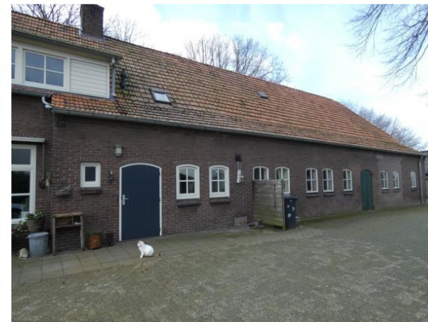
De gevel van het achterhuis met oorspronkelijke indeling. Links de twee vervangen betonvensters.
