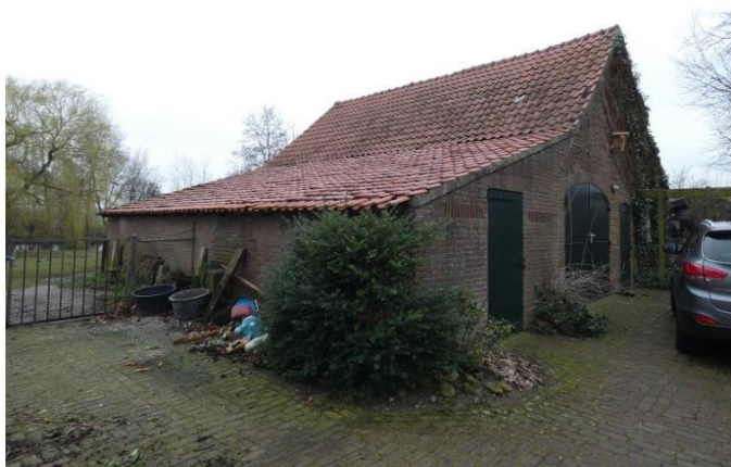
Afb. 3 Vrijstaand volume achter de boerderij, gebouwd in de jaren zestig en in meerdere fasen aan de oostzijde uitgebreid.
