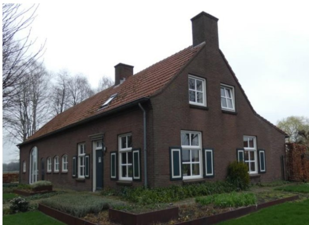
Noord- en westgevel.
