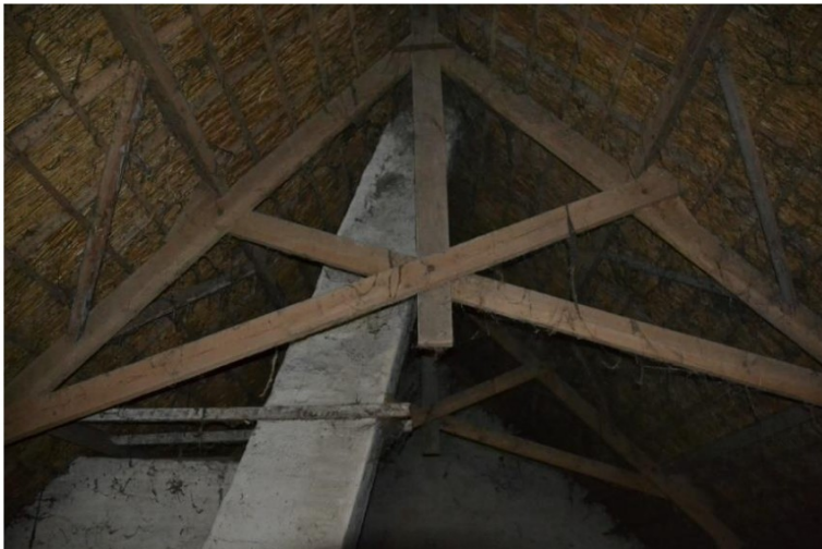
Detail van één van de spanten en één van de rookkanalen.
