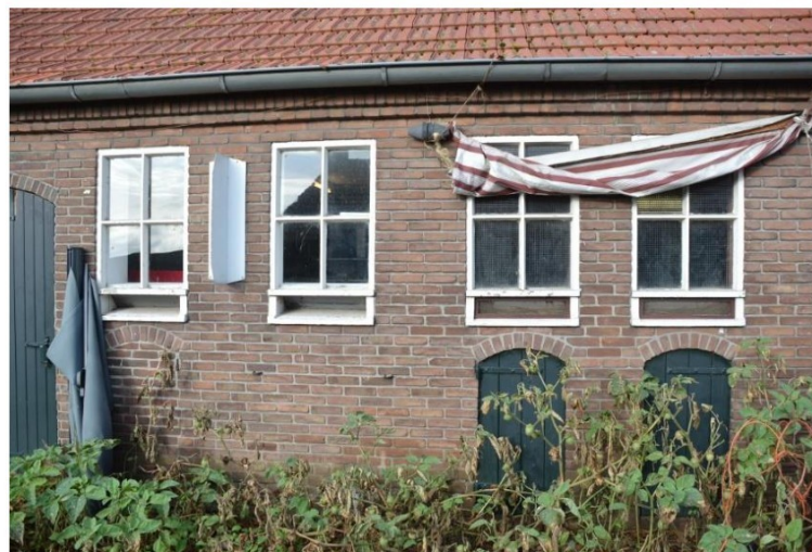
Betonnen stalramen met daaronder de varkensdeurtjes.
