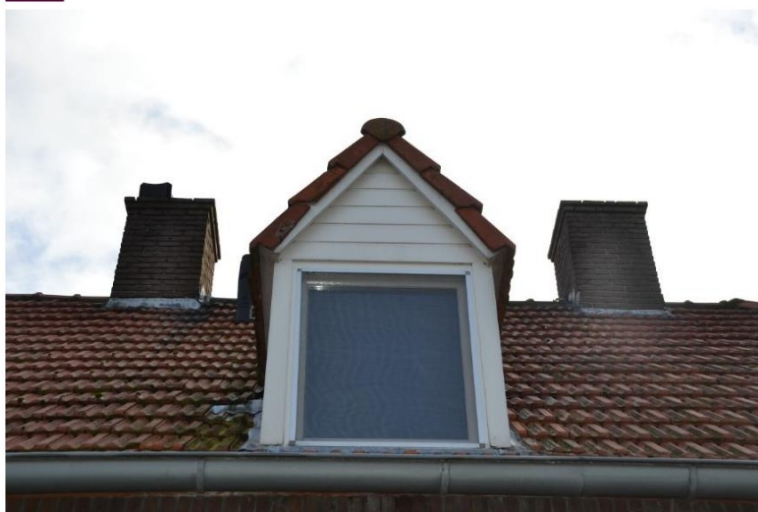
De dakkapel met op de achtergrond beide schoorstenen.
