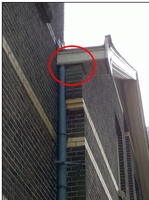
Figuur 12 voorbeeld van opening langs dakrand bij Martha gebouw
