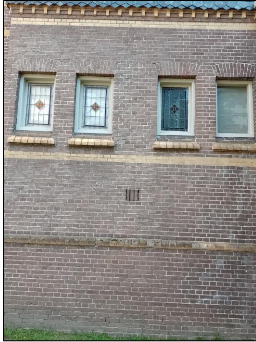
Figuur 14 Open stootvoeg aan hoofdgebouw oostelijke vleugel
