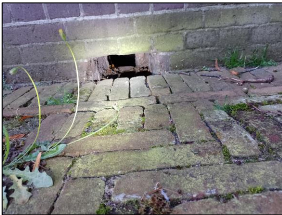
Figuur 16 Opening naar de kelder van het hoofdgebouw
