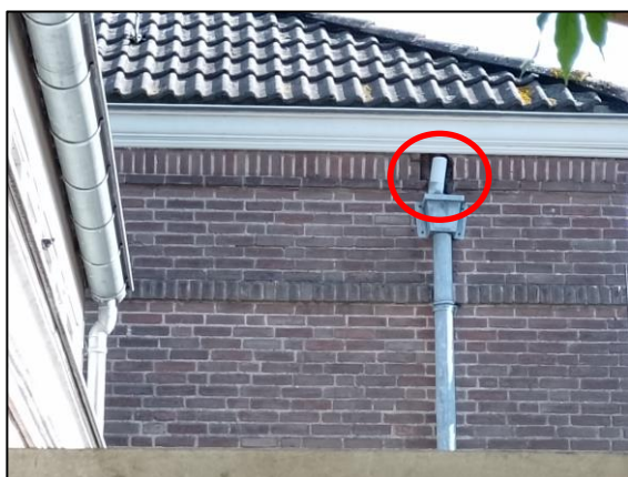
Figuur 18 Voorbeeld van openingen langs de dakgoot waar huismus kan nesten
