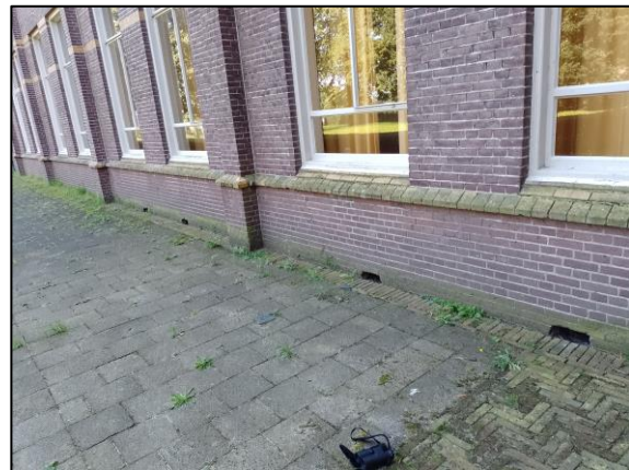
Figuur 17 Verschillende openingen naar de kelder van hoofdgebouw
