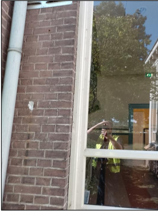
Figuur 13 Voorbeeld van kier langs kozijnrand waar vleermuizen gebruik van zouden kunnen maken
