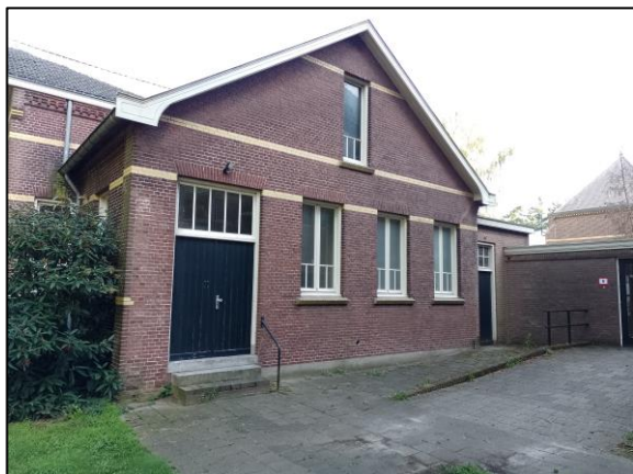
Figuur 2 Aanzicht van Martha gebouw zuidoostelijke zijde
