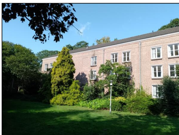
Figuur 6 aanzicht Martha gebouw Noord oostelijke zijde
