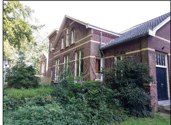
Figuur 3: aanzicht van Martha gebouw zuidelijk zijde
