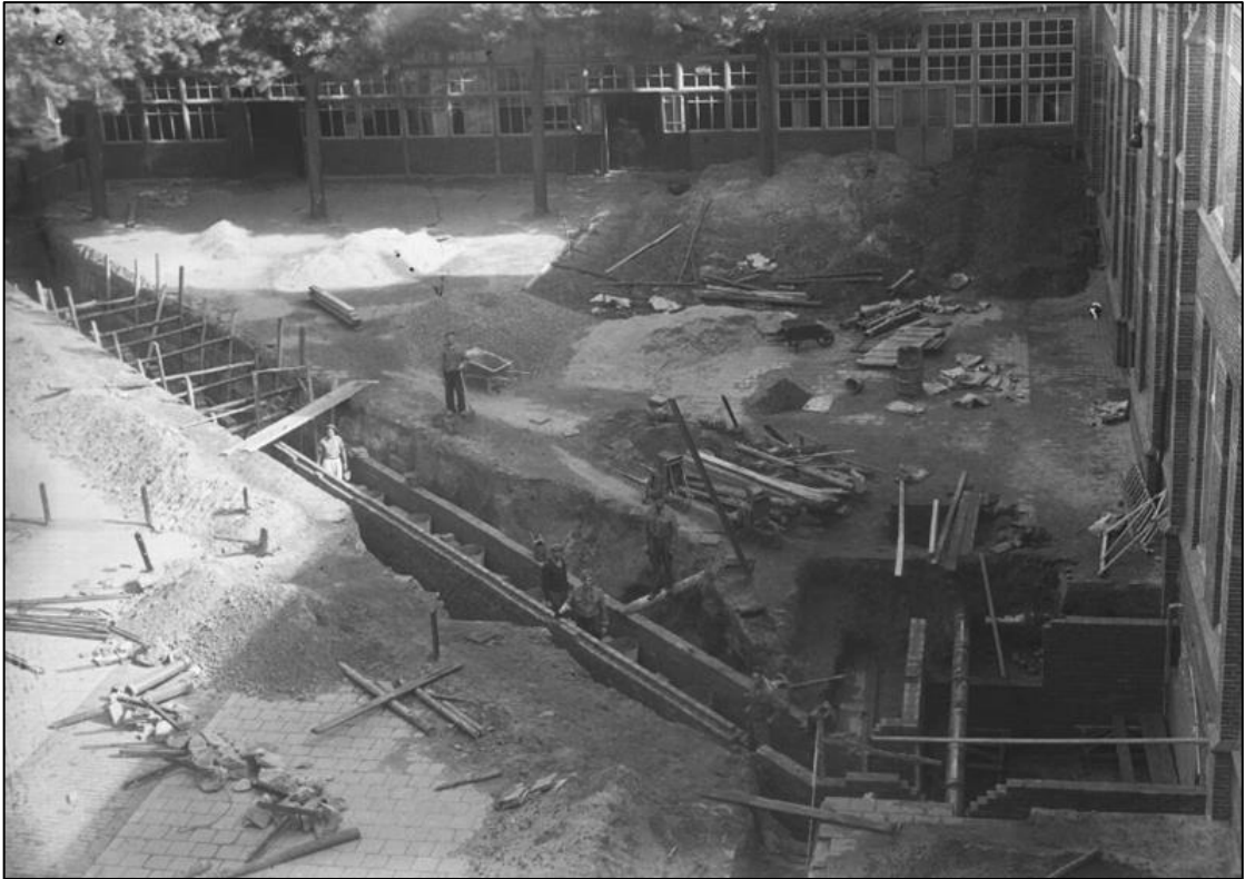
Afbeelding 14: 'Terrein Instituut voor Doven; afbraak speelplaatsen voor de aanleg van verwarming', d.d. 07-09-1946 (Bron: BHIC).
