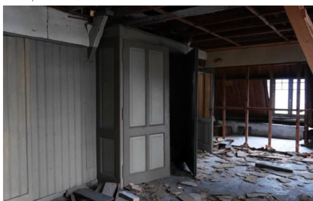
zolder hoekgebouw meisjeszijde
