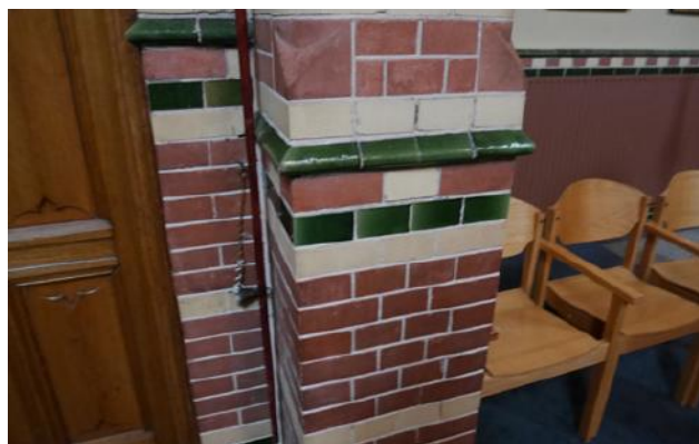
details geglaazuurde bakstenen en gele verblendstenen
