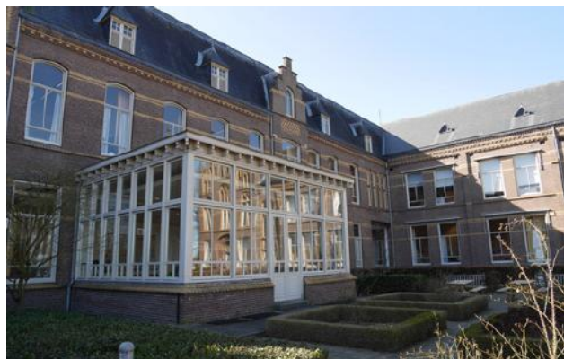
achtergevel met erkerzaal
