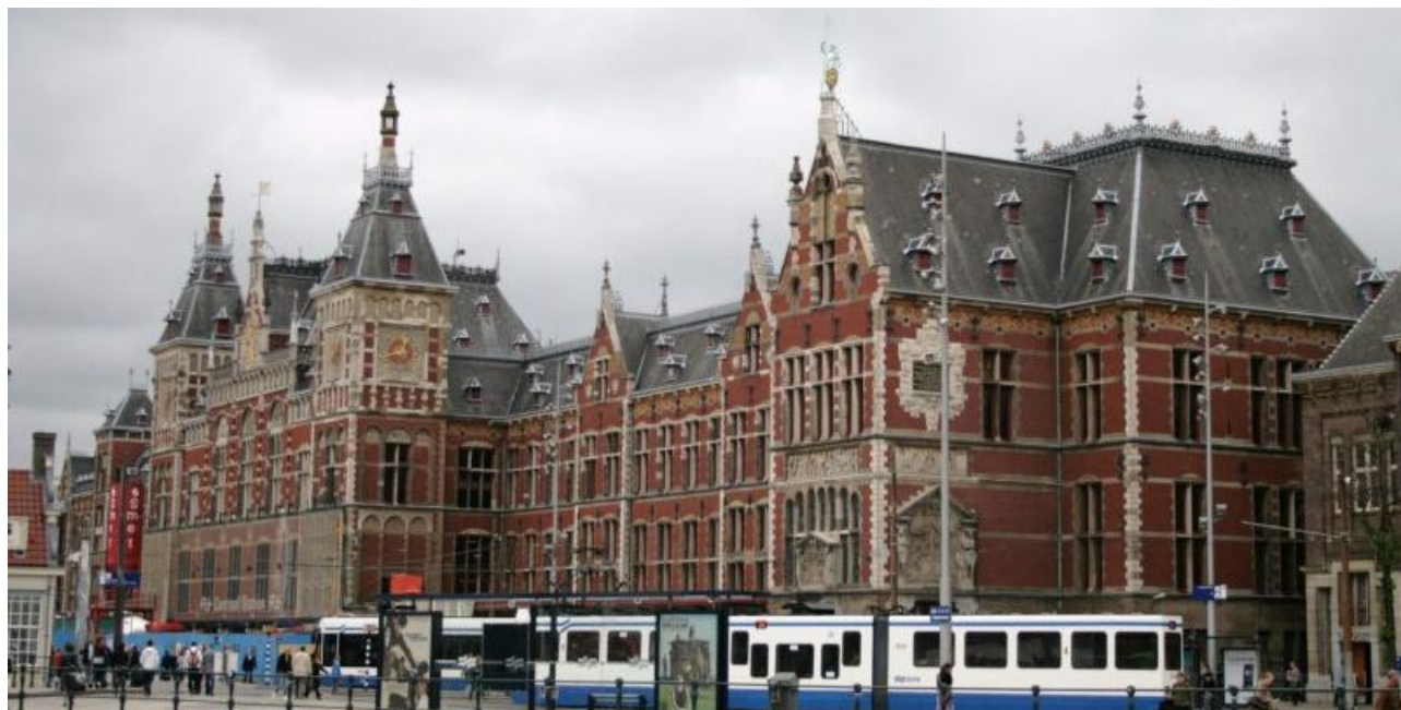
station Amsterdam in neorenaissance bouwstijl, P. Cuypers
