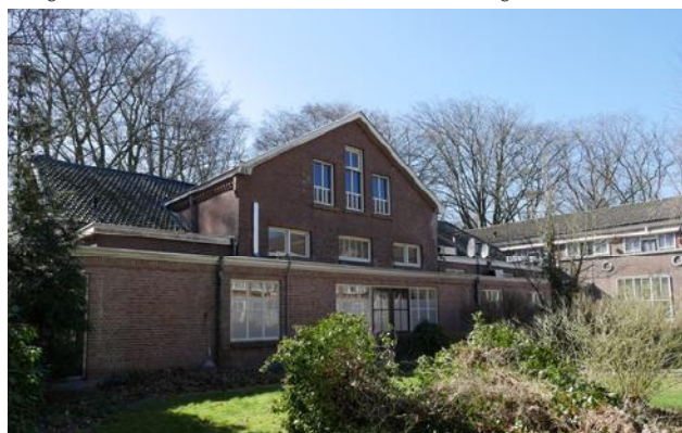
achtergevel, op de begane grond de gang uit 1954
