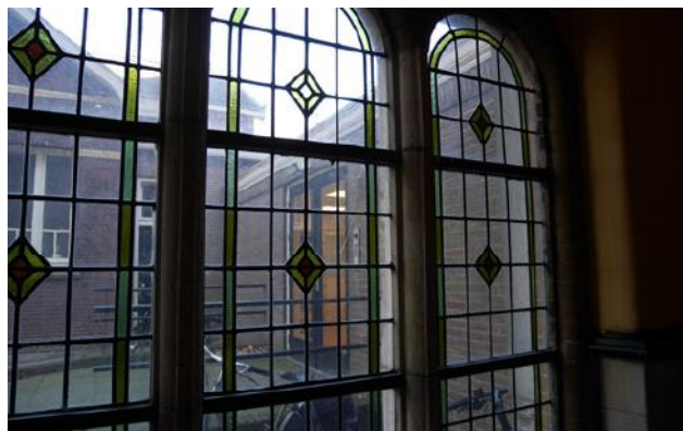
glas in lood venster in de traptoren meisjeszijde
