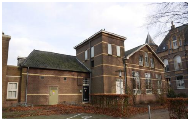
voorgevel, centraal de oude watertoren, links voormalige trafohuis
