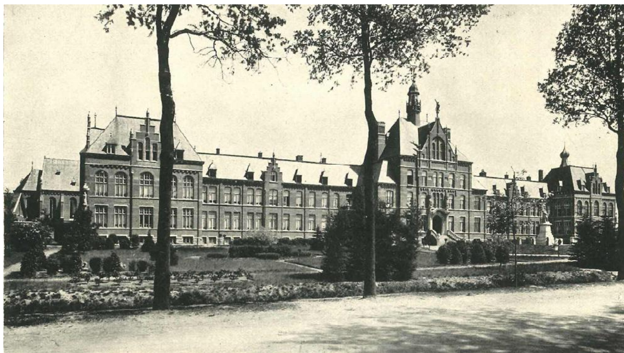
foto voorgevel, na 1915 (IVD)
