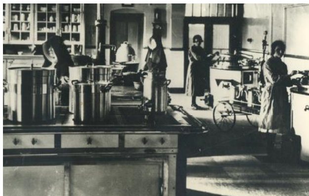
centrale keuken (IVD)
