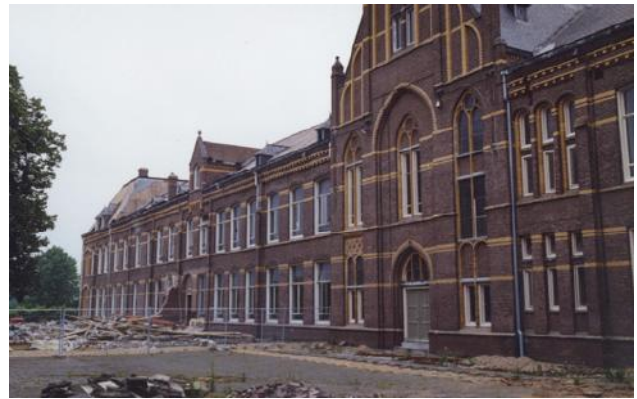
rechter achtervleugel voor de sloop (IVD)
