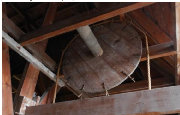
hijswiel zolder hoekgebouw meisjes
