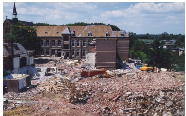
linker achtervleugel, half gesloopt deel voorschouw en speelzaal (IVD)
