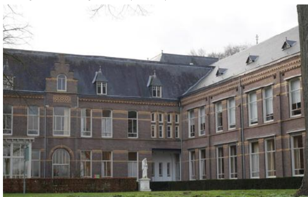
hoek zijvleugel en voorvleugel met terugliggend geveldeel
