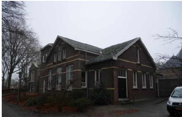
voorgevel en zijgevel, met wasserij en bergingen achter de gevels
