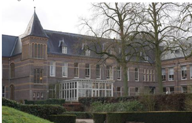
achtergevel voorvleugel met traptoren op de hoek
