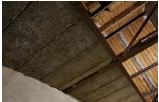
betonnen platen in het tongewelf van de slaapzolders
