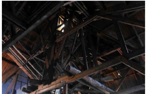
dakconstructie zolder priesterhuis
