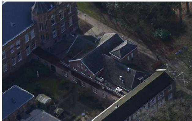
luchtfoto, kruisvormig dak van de wasserij, rechts boven de watertoren
