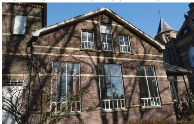
voorgevel wasserij met nieuwe vensters
