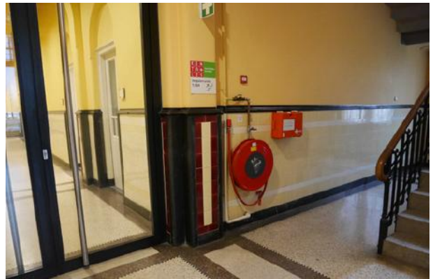
nieuwe tussendeuren in de hal van het trappenhuis jongenzijde
