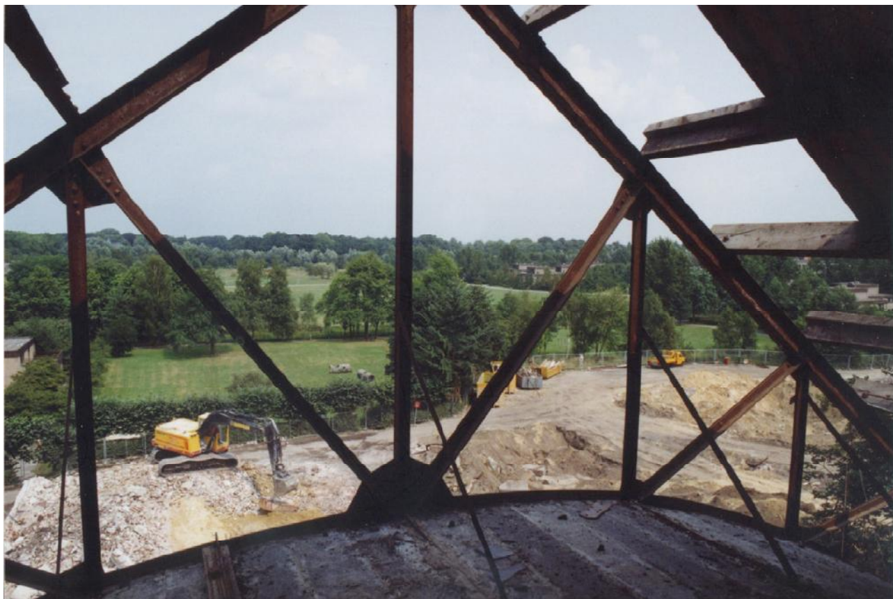
stalen spant en betonnen tongewelf van de achterste slaapzaal aan de meisjeskant, in 1989 afgebroken
