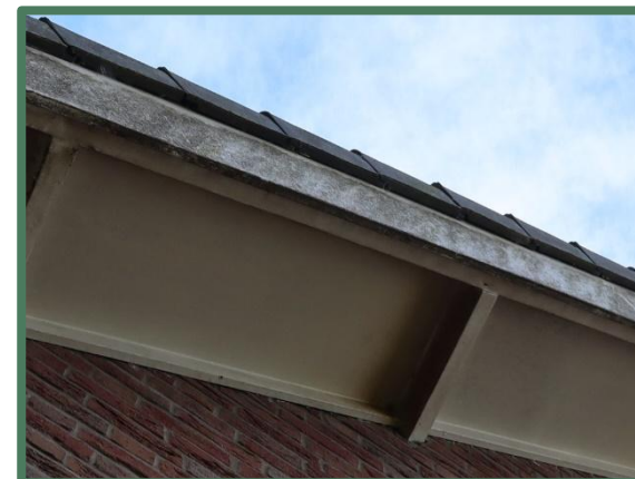
Foto 25: Gesloten dakranden en strakke kantpannen woning.
