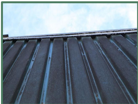
Foto 24: Gesloten dakrand opslagplaats.
