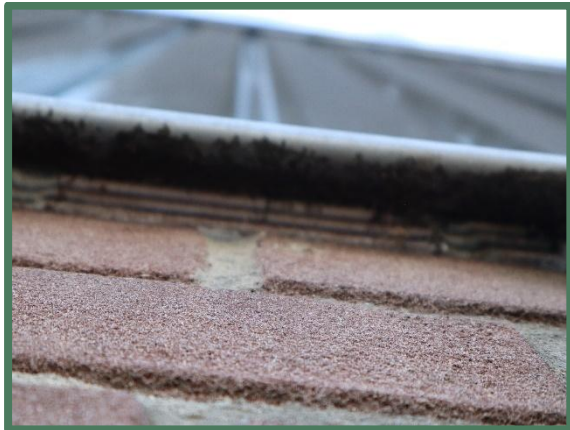
Foto 22: Gesloten rand onder damwand.
