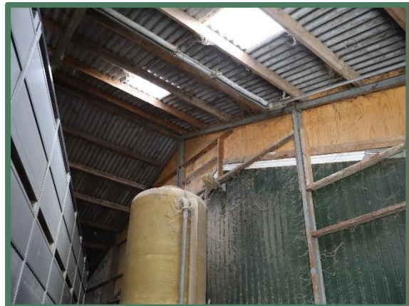
Foto 8: Overzicht binnenzijde opslagplaats.
