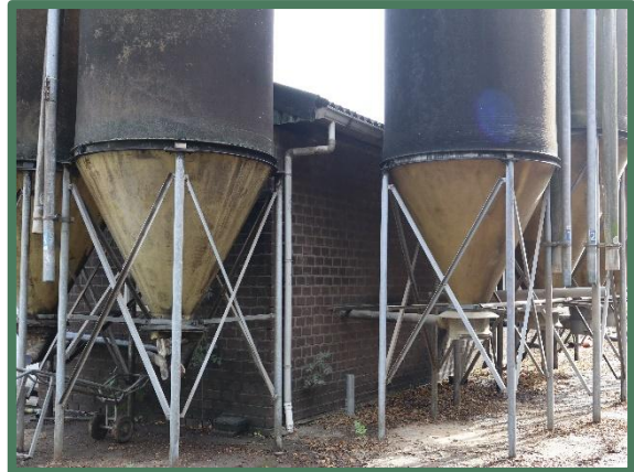
Foto 10: Kleine silo's naast varkensstallen.
