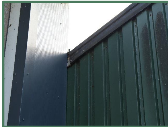
Foto 23: Gesloten randen aansluiten stallen en opslagplaats.
