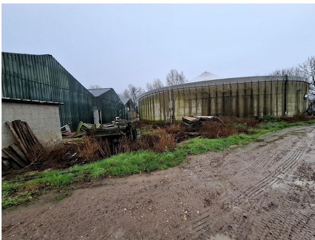
Foto 10: Achterzijde (zuidzijde) van de grote schuur met daarachter de silo. Tegen de gevel van de schuur vindt materiaalopslag plaats. Op het maaiveld is een bijmenging met grind zichtbaar.
