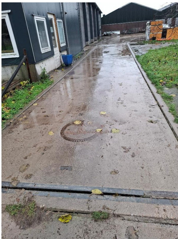
Foto 4: Weegbrug aan de westzijde van de 'kleine schuur'.
