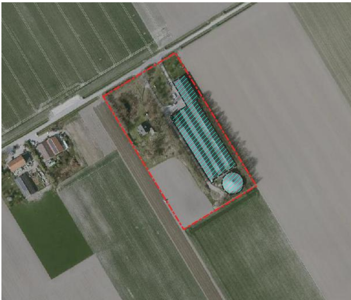
Figuur 1: Kadastraal perceel onderzoekslocatie (rood omlijnd) en locatie van de te slopen bedrijfsbebouwing (blauw gearceerd) weergegeven op de luchtfoto van 2025. Bron: PDOK
