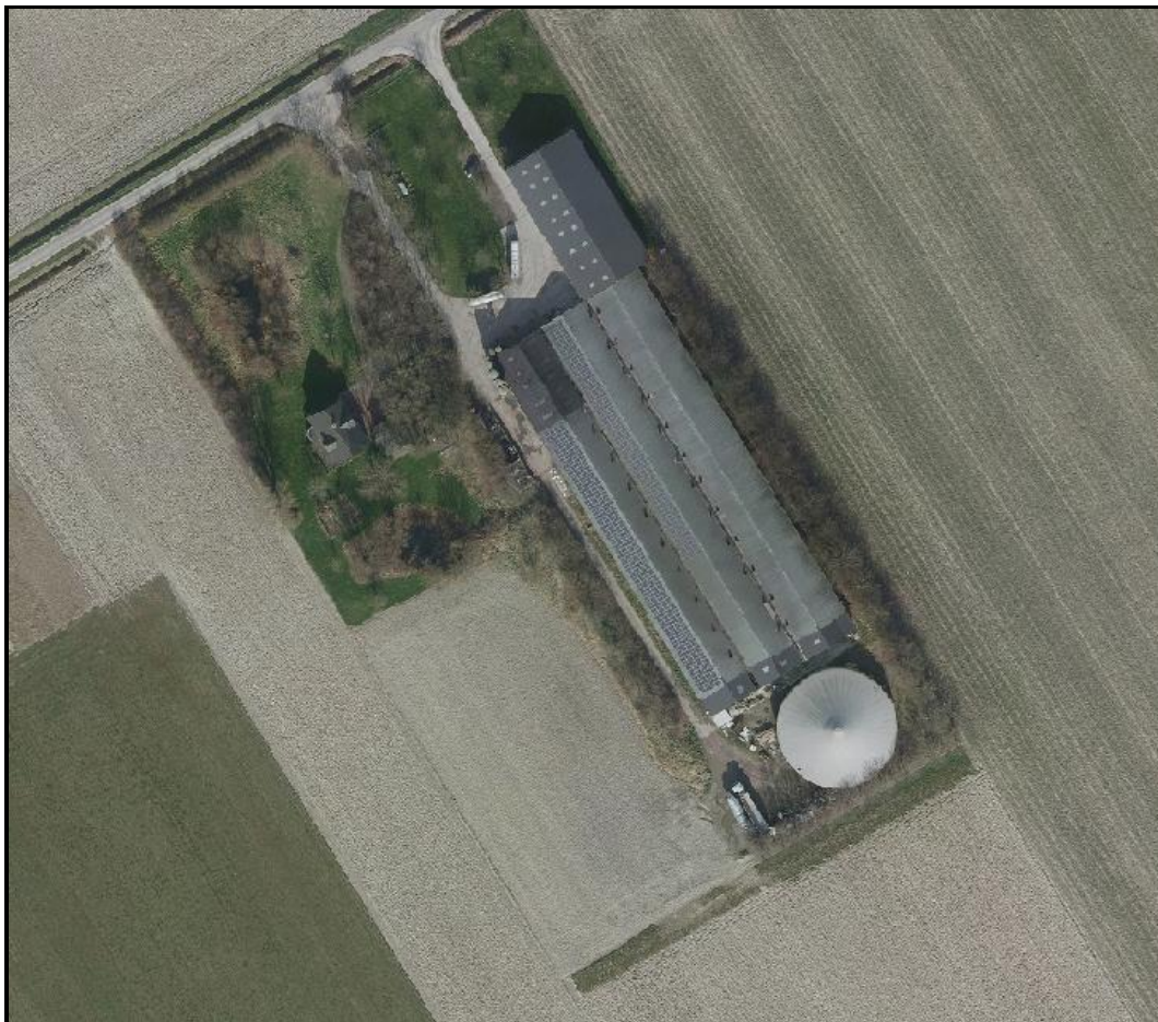
Figuur 2: Luchtfoto Groeneweg Oost 1 Schoondijke (Geoweb zeeland)
