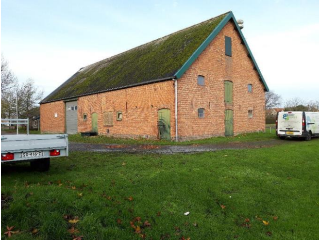
Foto 1. Kijkend naar noordwestelijke richting vanuit boorpunt 8
