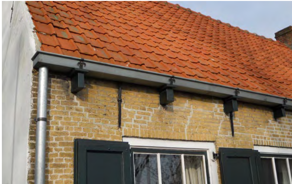
gootklossen en muurankers
