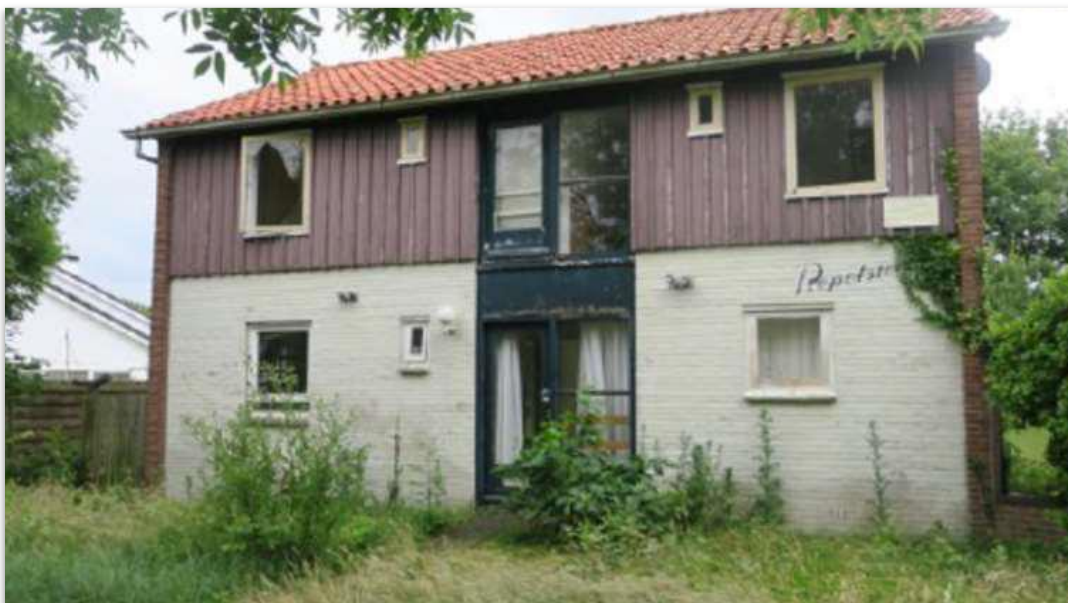
Figuur 4: Huidige situatie Boulevard de Wielingen 25 (Bron: Quicksan Blom Ecologie)
