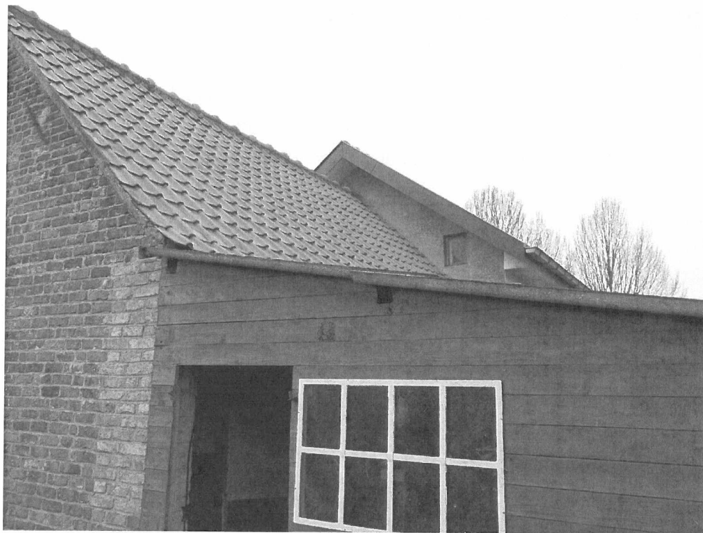
Foto 2. Te slopen schuur.
