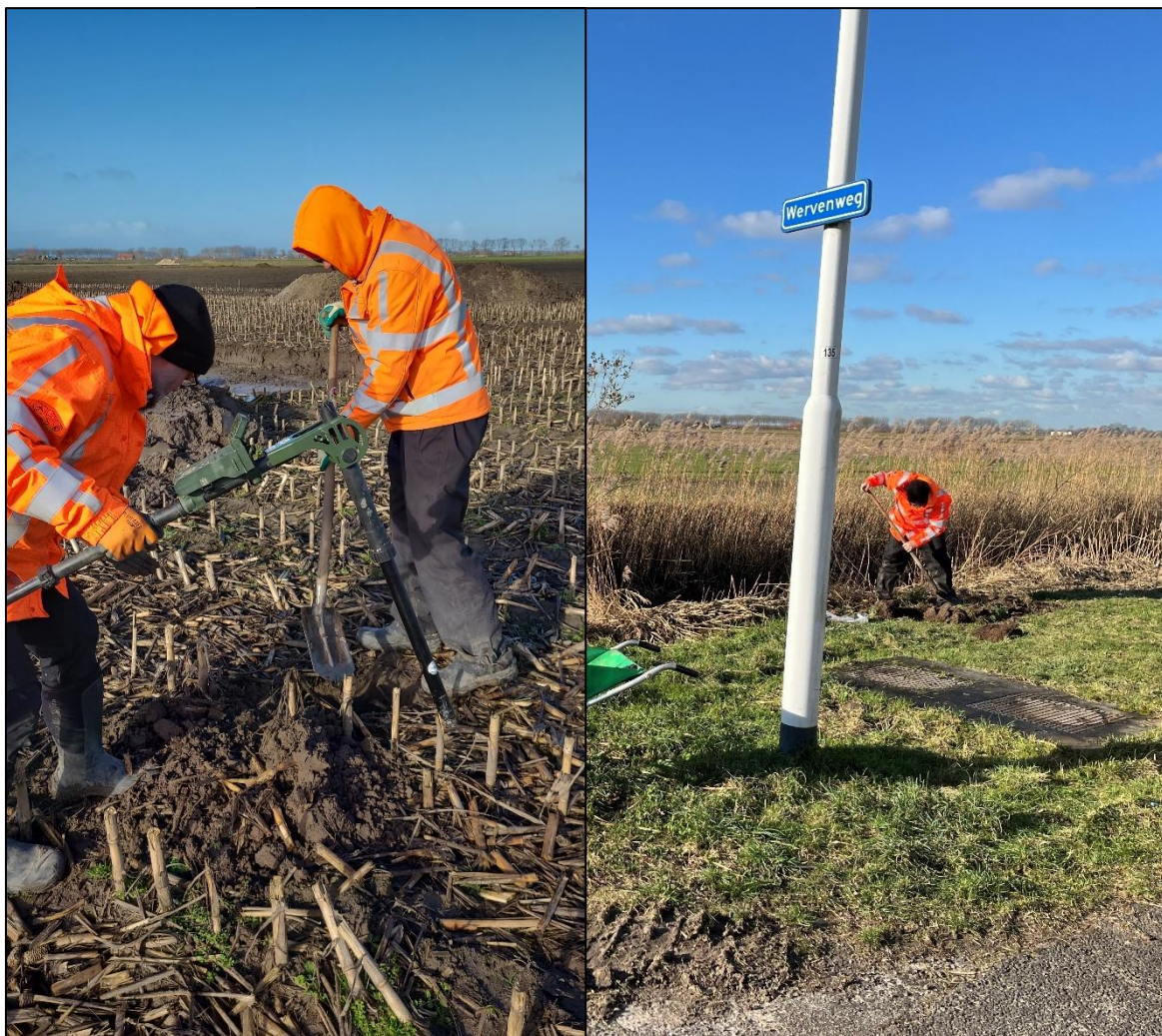
Afbeelding 2: Werkzaamheden op projectlocatie (Bron: Euroradar).
