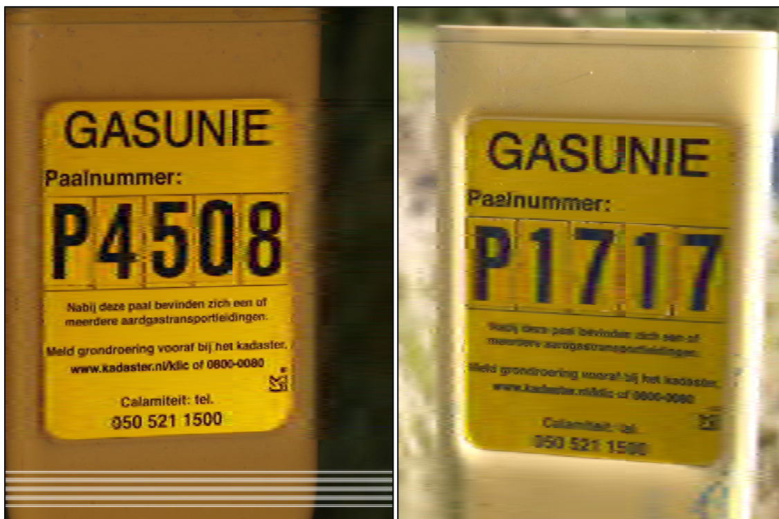
Afbeeldingen 26-27 In de zuidwesthoek van het plangebied loopt een hogedruk gasleiding (zie gele lijn afbeelding 24). Ter hoogte van de letter A staat Paalnummer P4508, ter hoogte van B Paalnummer P1717.
