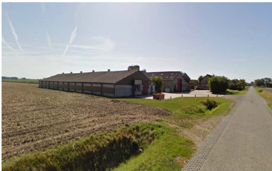
zicht op locatie vanuit noordelijke richting
