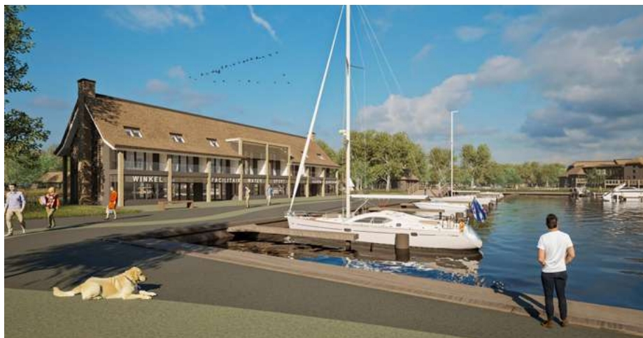
Figuur 84 Zicht vanaf de kade op passantenhaven en havengebouw
