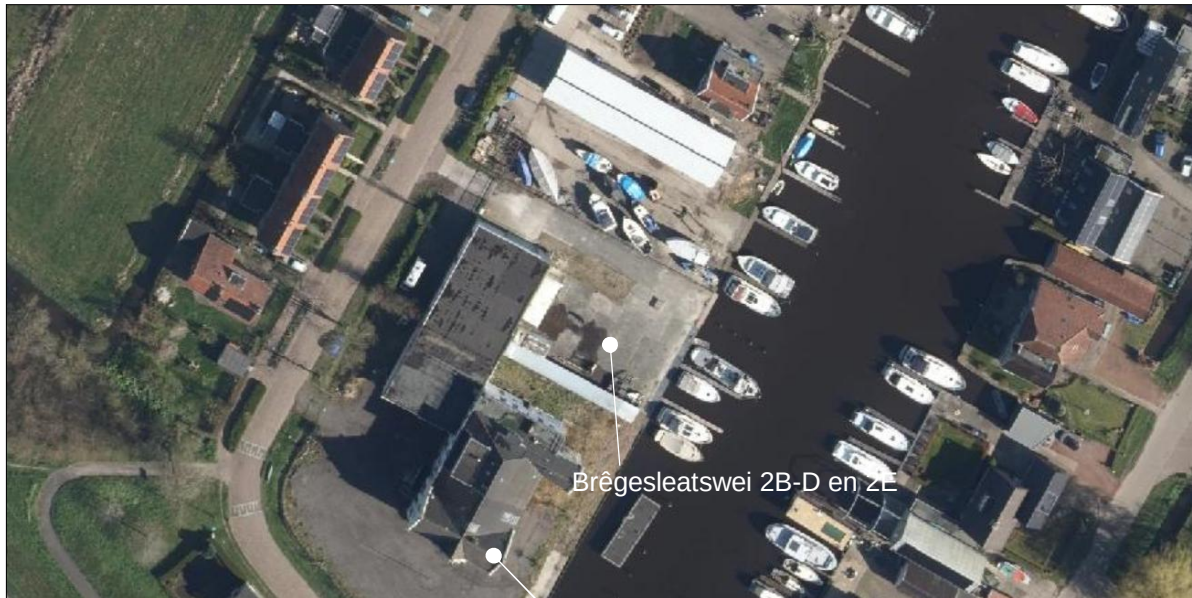
Afbeelding 1: Luchtfoto bestaande situatie
