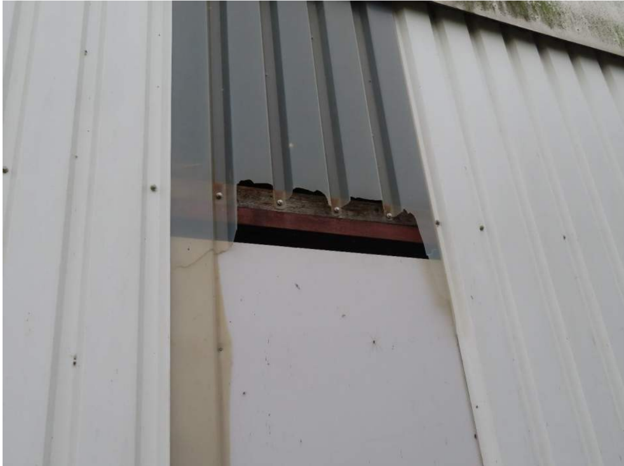
Figuur 2.4: De oude zuivelfabriek is voor soorten als gewone grootoorvleermuis toegankelijk.
