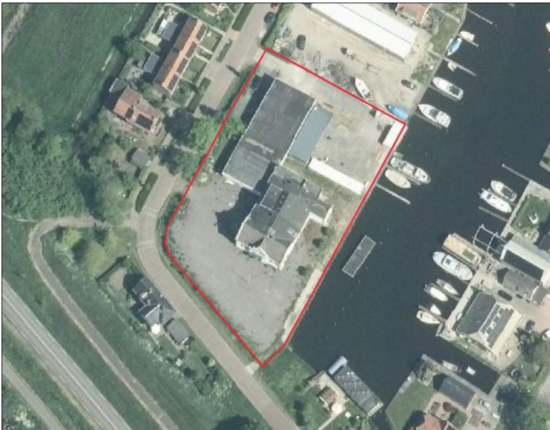
Figuur 2.1 Luchtfoto bestaande situatie
