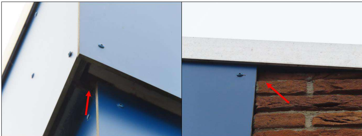
Figuur 2.4. Onder daklijsten en in de muren van de school zijn ruimten aangetroffen die geschikt zijn bevonden als (doorgangen tot) verblijfplaatsen van vleermuizen.
