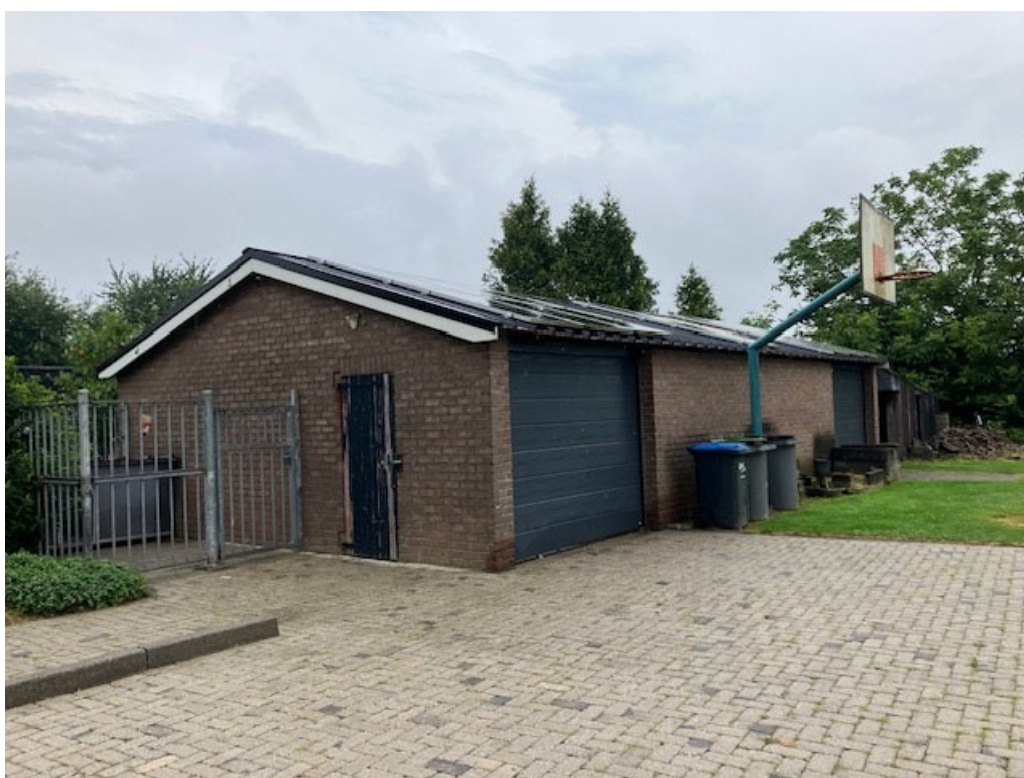
• Afbeelding 8: Bestaand bijgebouw bij de bedrijfswoning, blijft gehandhaafd
