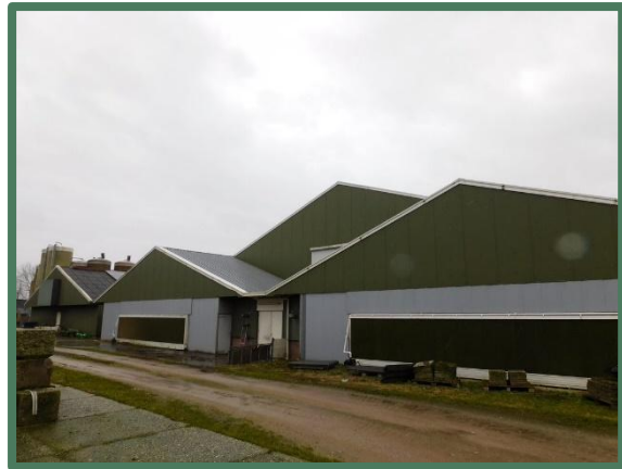
Foto 10: Noordzijde van enkele van de te slopen stallen.
