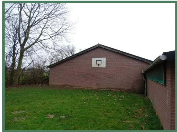
Foto 4: Noordzijde van een van de te slopen stallen.
