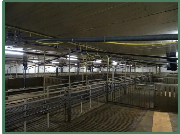
Foto 16: Binnenzijde van een van de te slopen stallen.
