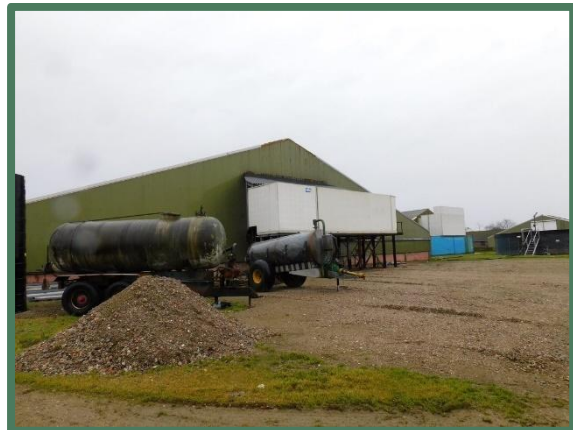
Foto 12: Zuidzijde van een van de te slopen stallen.
