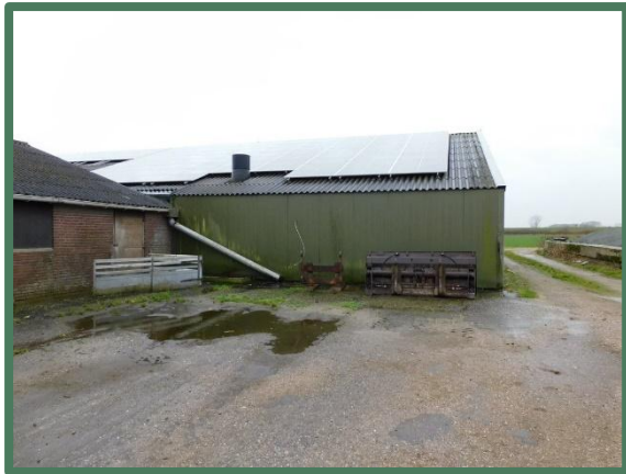
Foto 9: Oostzijde van een van de te slopen stallen.
