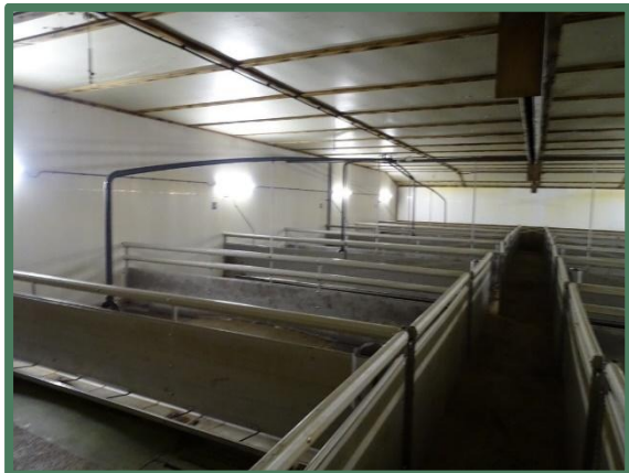
Foto 13: Binnenzijde van een van de te slopen stallen.
