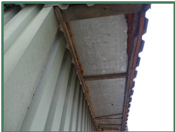
Foto 29: Kieren gedicht met oud purschuim.
