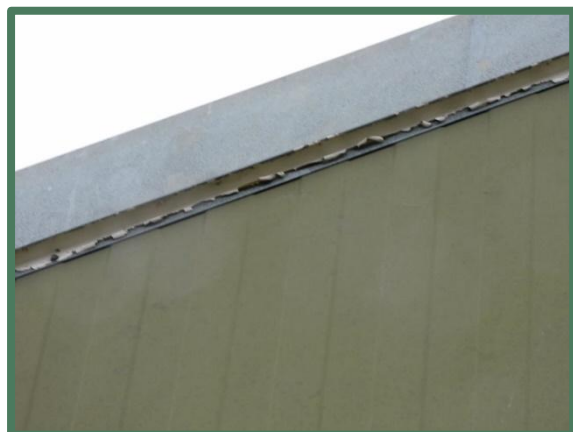
Foto 28: Strak aansluitend boeiboord.
