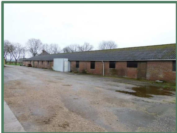
Foto 7: Westzijde van een van de te slopen stallen.
