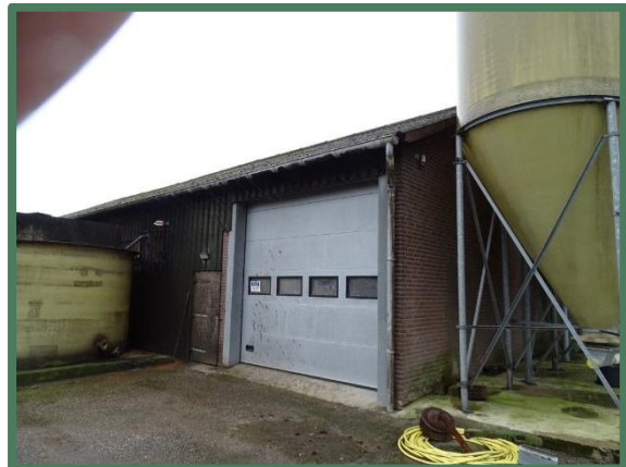
Foto 8: Oostzijde van een van de te slopen stallen.
