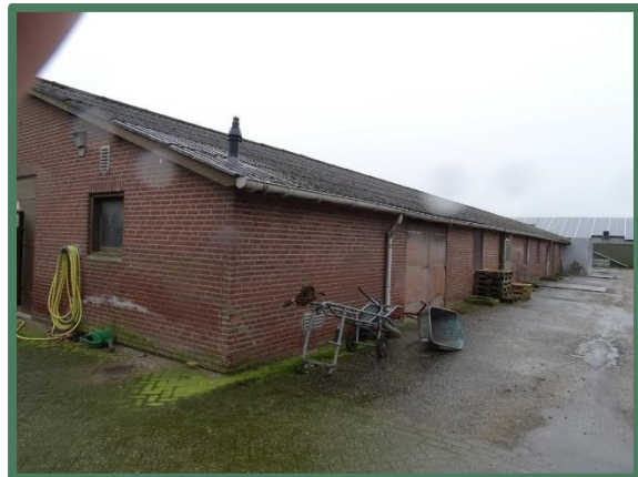
Foto 6: Westzijde van een van de te slopen stallen.
