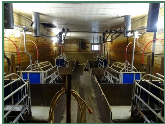
Foto 14: Binnenzijde van een van de te slopen stallen.
