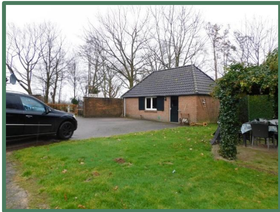
Foto 3: Oostzijde bijgebouw van bedrijfswoning.
