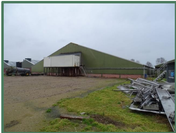
Foto 11: Zuidzijde van een van de te slopen stallen.
