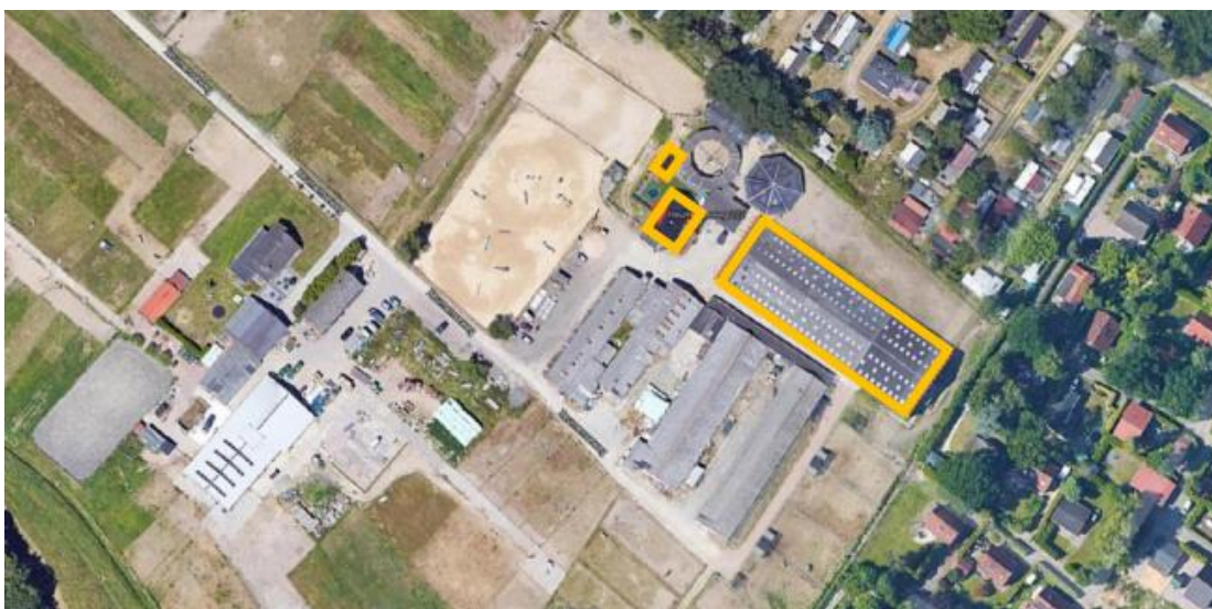
Afbeelding 2: Luchtfoto met te handhaven bebouwing met geel kader weergegeven, te weten de woning met garage en loods (bron 2)
