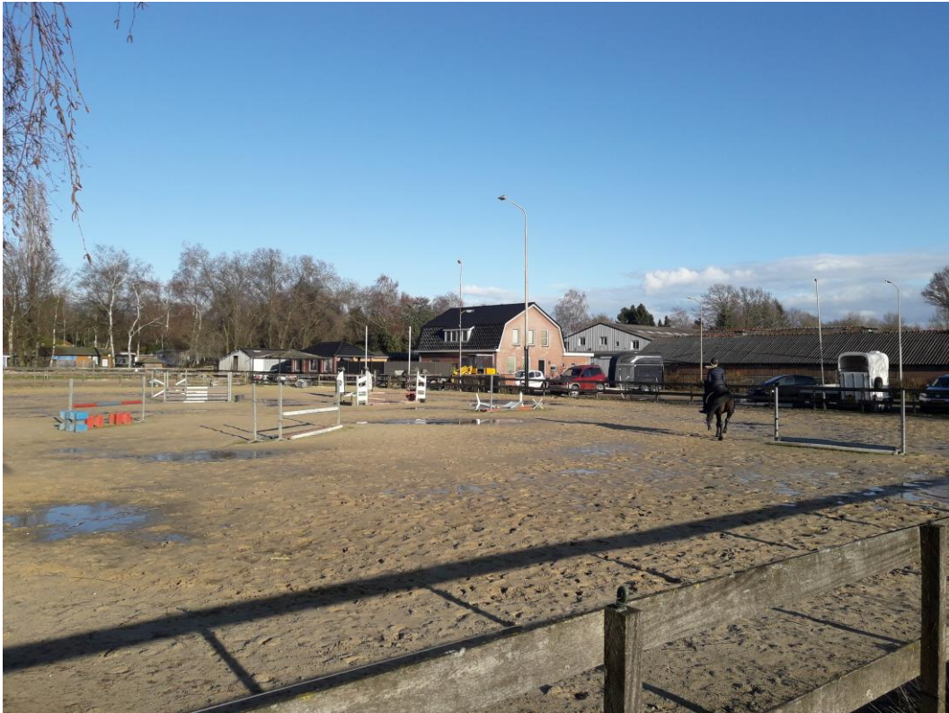
Te slopen opstallen, te saneren verharding en buitenopslag (rechts) en te behouden woning (links)
