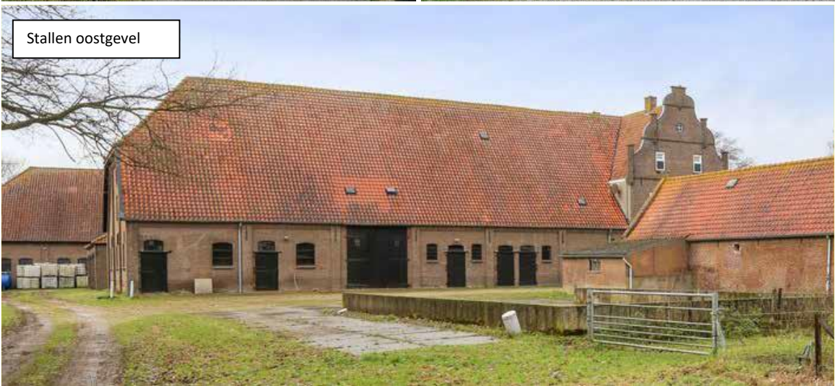
Afbeelding 2.2: Foto's bestaande situatie
